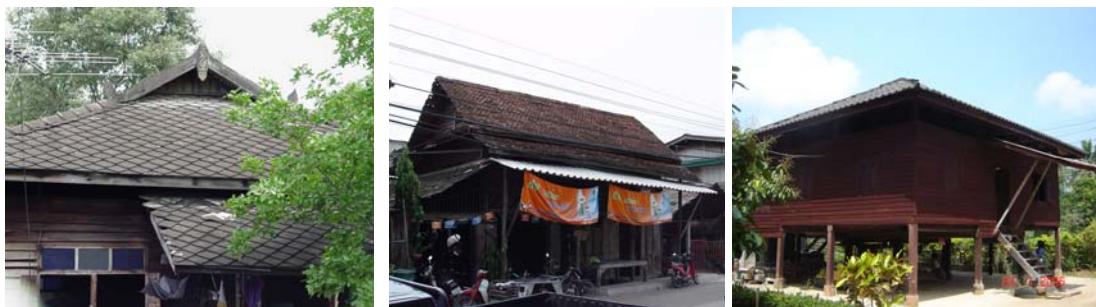
ภาพที่ 5.15 แสดงอาคารพักอาศัยแบบลักษณะพื้นบ้าน
