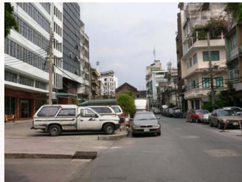
ภาพที่ 4-12 อาคารใหม่บริเวณถนนอนุวงศ์
