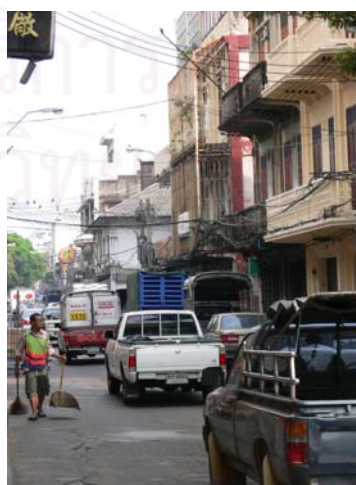
ภาพที่ 5-50 การใช้อาคารบริเวณถนนทรงวาด
