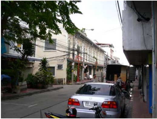
ภาพที่ 4-9 อาคารบริเวณถนนทรงวาด
