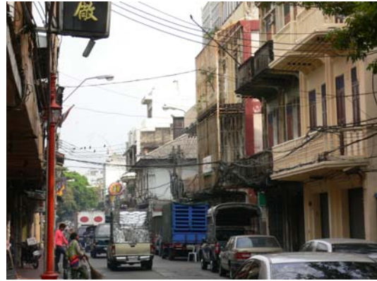
ภาพที่ 4-10 อาคารบริเวณถนนทรงวาด
