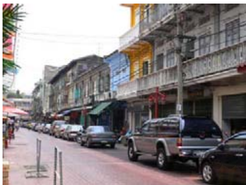
ภาพที่ 5-26 อาคารบริเวณถนนพาดสาย
