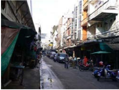
ภาพที่ 5-11 สภาพอาคารบริเวณถนนมหาจักร
