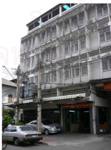
ภาพที่ 5-49 การใช้อาคารบริเวณถนนทรงวาด
