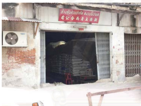
ภาพที่ 5-47 การใช้อาคารบริเวณถนนทรงวาด
