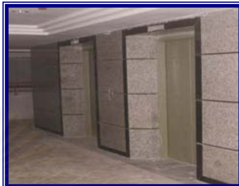
8. ลิฟต์โดยสารภายในอาคารชุด
