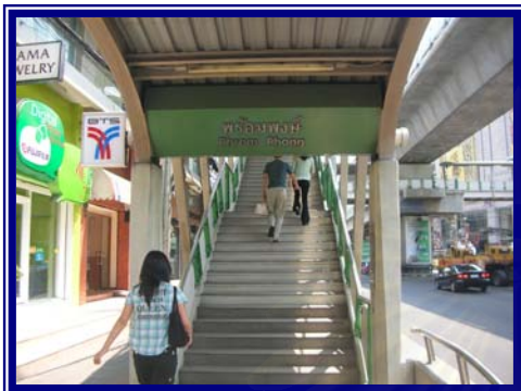
1. สถานีรถไฟฟ้า BTS
