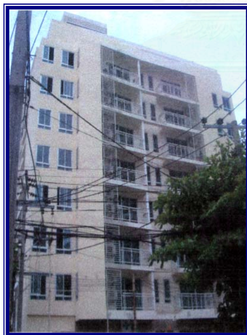
23. 49 พลัส คอนโดมิเนียม
