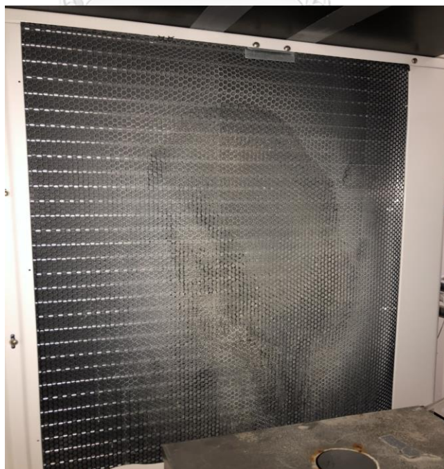
รูปที่ 20 การเกิดตะกรันขวางทางการไหลอากาศ
