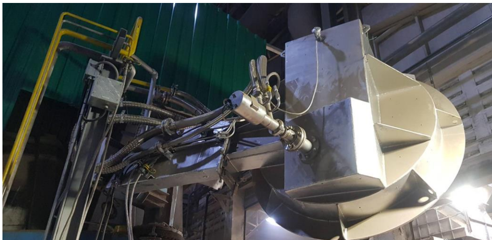
ภาพที่ 40 ฉากอลูมิเนียมขึ้นบริเวณเตาหลอม
