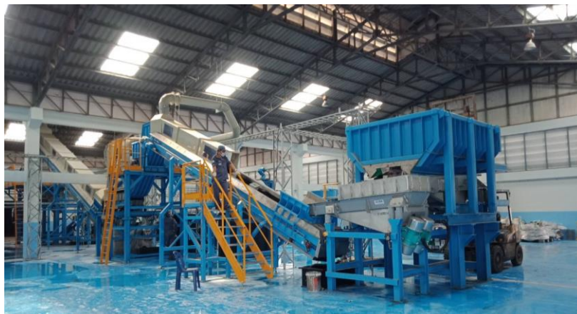
ภาพที่ 31 การติดตั้งระบบรวบรวมฝุ่นตะกั่วบริเวณหัวและท้ายสายพานแต่ละสาย
