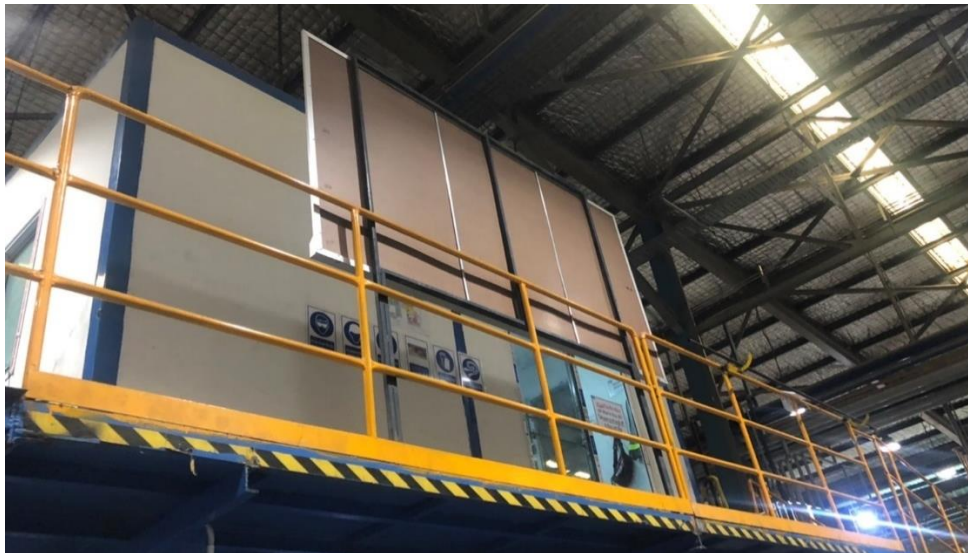
ภาพที่ 39 ติดประกาศเตือน และจัดทำมาตรการที่เคร่งครัดในการปฏิบัติงาน
