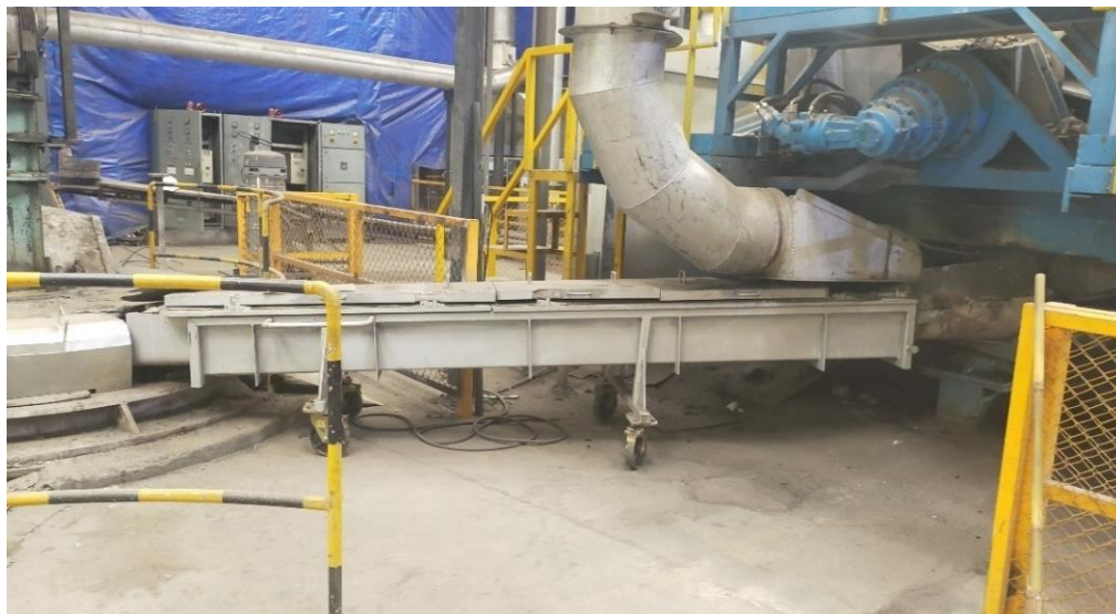
ภาพที่ 44 ฝาครอบรางลำเลียงตะกั่วจากเตาหลอมไปยังกระทะทำความสะอาด
