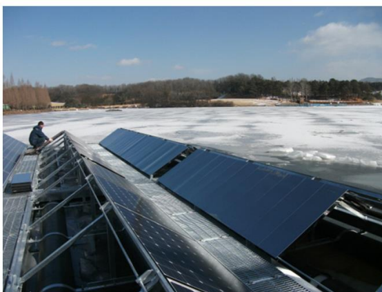
รูปที่ 2.24 เซลล์สุริยะแบบลอยน้ำชนิดแพแยกส่วนที่ใช้วัสดุโพลีเอทิลีนและเหล็กชุบสังกะสีในประเทศเกาหลีใต้
