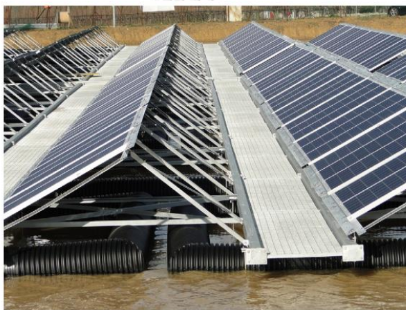
รูปที่ 2.23 เซลล์สุริยะแบบลอยน้ำชนิดแพแบบแยกส่วนใส่เหล็กชุบสังกะสี
