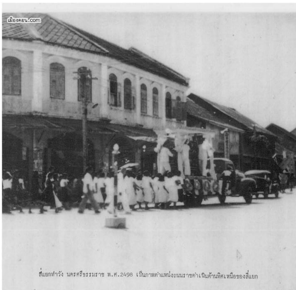
ภาพที่ 9 แสดงภาพถ่ายชุมชนท่าวังในอดีต อาคารเป็นเรือนแถวไม้ 2 ชั้น และตึกแถวรูปแบบโค
