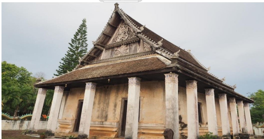
ภาพที่ 90 อุโบสถหลังเก่าวัดตะปอนน้อย อำเภอลำลูกเกด จังหวัดจันทบุรี
