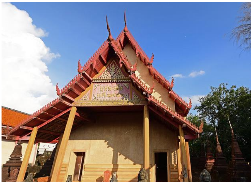
ภาพที่ 112 พระอุโบสถวัดบุปผาราม จังหวัดตราด
