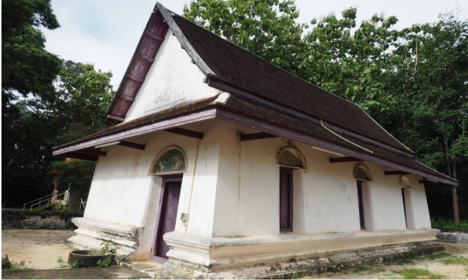
ภาพที่ 78 อุโบสถหลังเก่าวัดคลองน้ำเค็ม อำเภอแหลมสิงห์ จังหวัดจันทบุรี
