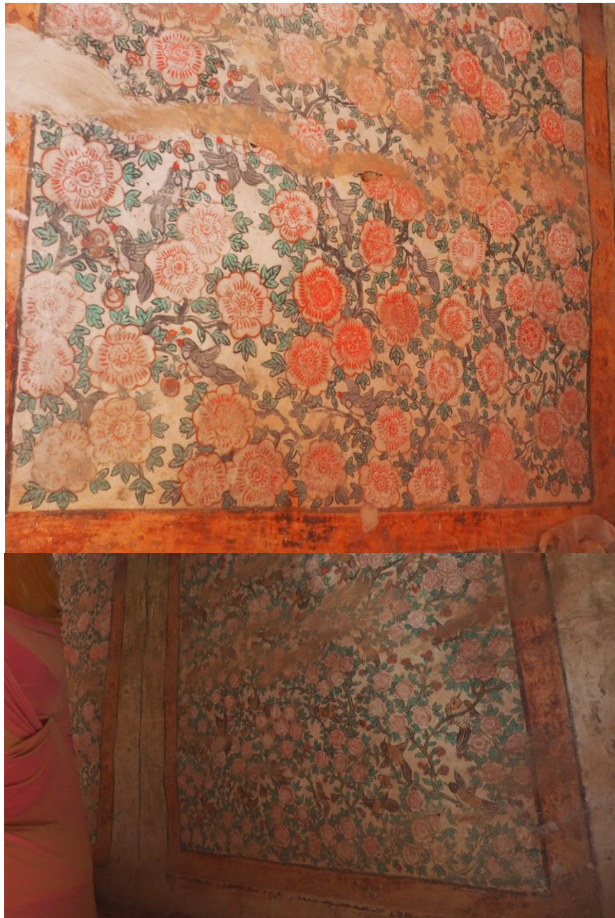
ภาพที่ 122 ภาพจิตรกรรมฝาผนังหุ้มกลองด้านหลังพระประธานเขียนเป็นภาพลายดอกกุหลาบแทรกภาพนก เป็นจำนวนมาก อยู่ในกรอบผ้าม่านที่แขวนห้อยลงเป็นผืนเรียบคล้ายฉากที่ฝาผนังด้านข้างเหนือช่องประตูเป็นลวดลายเหมือนกับฝาผนังด้านข้าง ซึ่งเขียนให้เห็นคล้ายราวกับฝาผนังเป็นดั่งหินอ่อน ถูกจัดให้อยู่ด้านหลังพระประธานอันเนื่องมาจากการให้พระประธานมีความงดงามมากขึ้น อีกทั้งยังทำให้พระประธานดูเด่นสง่างามอีกด้วย
