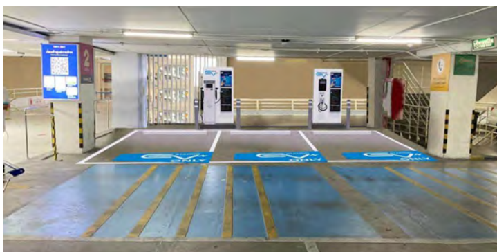
ภาพที่ 14 รูปแบบการติดตั้งเครื่องอัดประจุแบบห้างสรรพสินค้า
