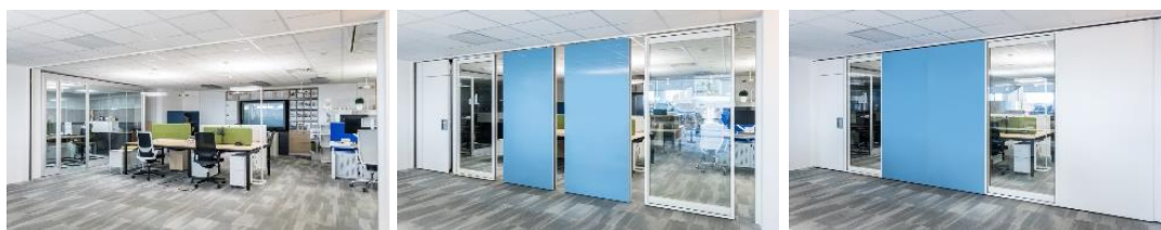
ภาพที่ 72 แสดงตัวอย่างการใช้ผนังแบบ Movable Partition กั้นแบ่งพื้นที่
