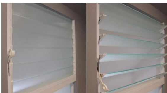
รูปที่ 43 เกล็ดระบายอากาศแบบหมุนปิด - เปิด ได้
