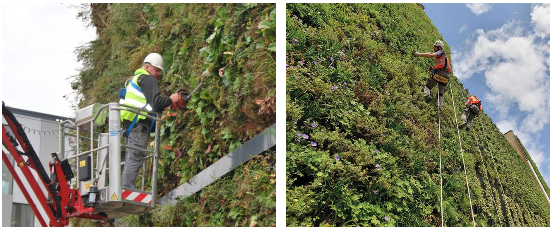
ภาพที่ 6 ภาพแสดงการบำรุงรักษาพื้นที่สีเขียวแนวตั้งนอกอาคาร
