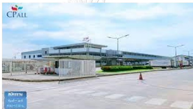
ภาพ 20 โครงการ CP ALL Distribution Center Mahachai
