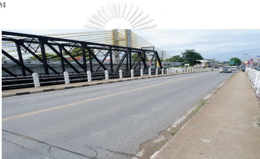
รูปที่ 48 การตรวจสอบพื้นสะพานในเวลากลางวัน
