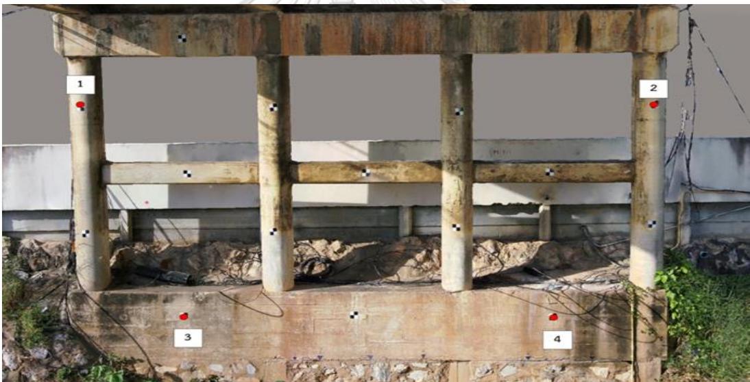
รูปที่ 23 จุดควบคุมภาพถ่ายส่วนตอม่อของสะพาน
