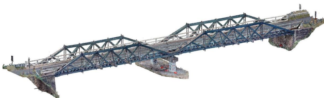
รูปที่ 10 แบบจำลองที่ได้จากการรังวัดภาคพื้นดินด้วยเลเซอร์สแกน (TLS)
