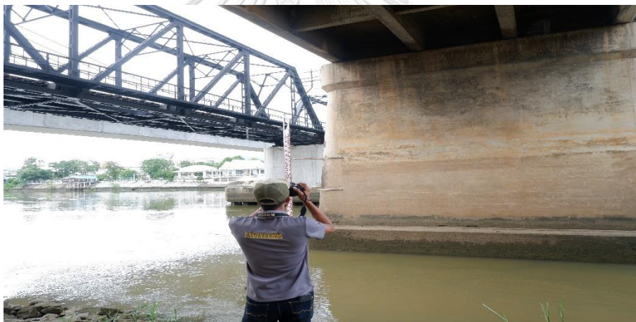
รูปที่ 52 การตรวจสอบท้องพื้นสะพาน
