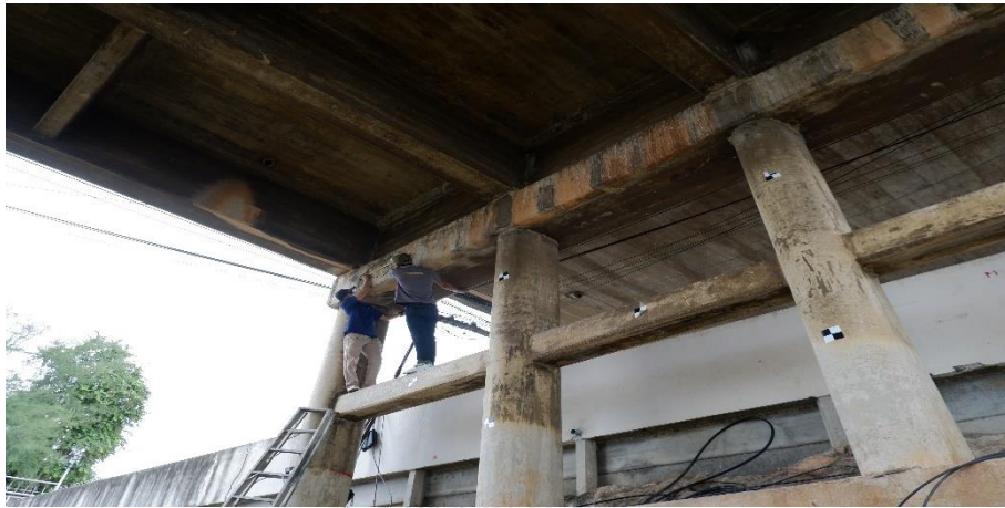
รูปที่ 51 การตรวจสอบตอม่อริมตลิ่ง
