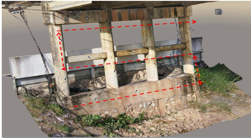
รูปที่ 20 รูปแบบการบินในส่วนตอม่อสะพาน
