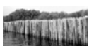
การติดตามและประเมินผลการฟื้นฟูระบบนิเวศชายฝั่งทะเลโดยการปักไม้ไผ่ชะลอคลื่น กรณีศึกษา จังหวัดสมุทรสงคราม สมุทรสาคร สมุทรปราการและฉะเชิงเทรา
