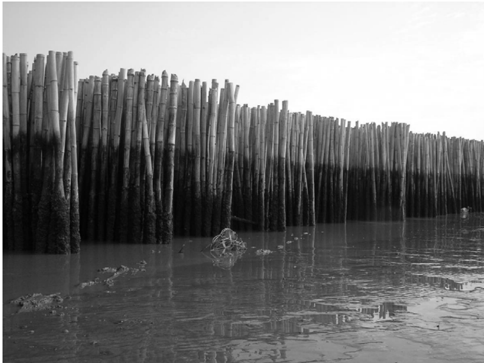
รูปที่ 3.4 การปักแนวไม้ไผ่ชะลอคลื่นที่บริเวณชุมชนบ้านขุนสมุทรณีรัตน์ ตำบลบางหญ้าแพรก จังหวัดสมุทรสาคร
