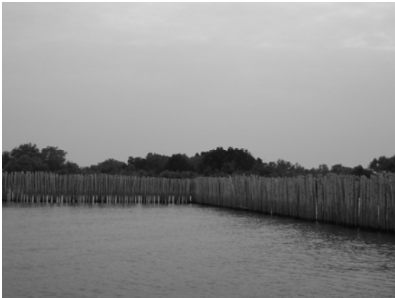
รูปที่ 3.13 การปักแนวไม้ไผ่ชะลอคลื่นบริเวณปากคลองหงษ์ทอง ตำบลสองคลอง จังหวัดฉะเชิงเทรา
