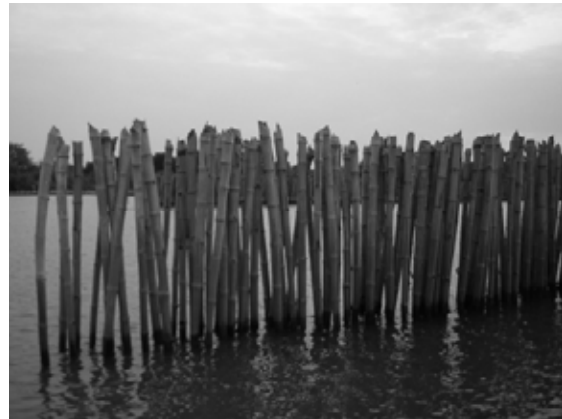
รูปที่ 3.13 การปักแนวไม้ไผ่ชะลอคลื่นบริเวณปากคลองหงษ์ทอง ตำบลสองคลอง จังหวัดฉะเชิงเทรา
