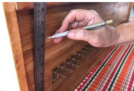
ภาพที่ 195 กำหนดตำแหน่งสอดสายลม ที่มา : ผู้วิจัย
