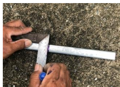
ภาพที่ 247 ขีดเส้นบนเหล็ก ที่มา : ผู้วิจัย
