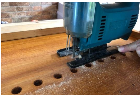
ภาพที่ 283 การเจาะช่องสำหรับสอดสายลม
