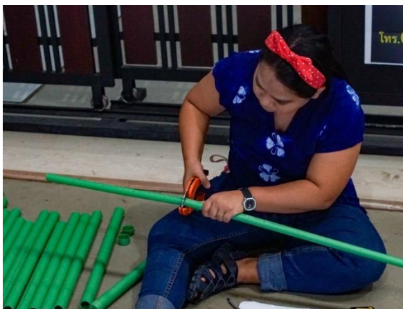
ภาพที่ 31 ตัดท่อ PPR
