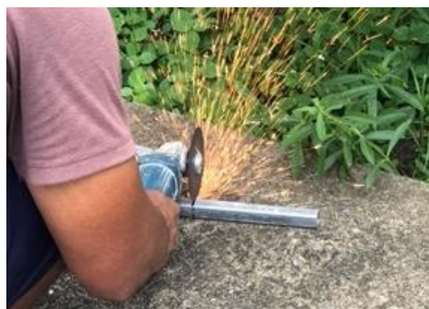
ภาพที่ 248 ตัดเหล็ก ที่มา : ผู้วิจัย
