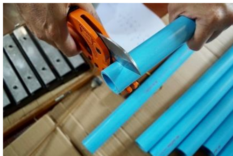
ภาพที่ 82 ตัดท่อลมรายขนาดใหญ่ ที่มา : ผู้วิจัย
