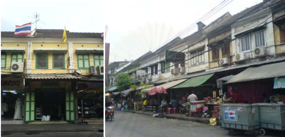
รูปภาพ 3.18 อาคารตึกแถวบริเวณถนนตะนาว
