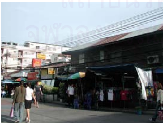
รูปภาพ 3.20 อาคารแถวไม้ริมถนนข้าวสาร
