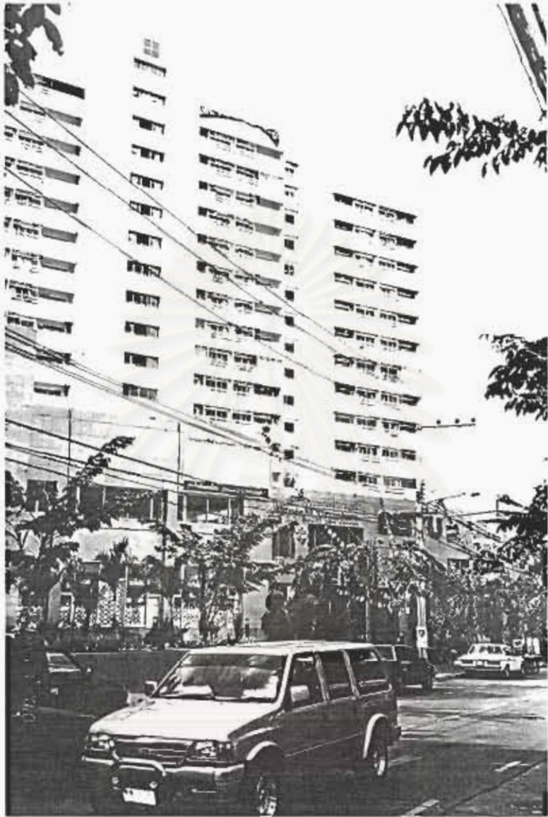
รูปที่ 3.25 : สภาพด้านหน้าอาคารในปัจจุบัน ตัดถนนเทศบาลนิมิตรเหนือ
