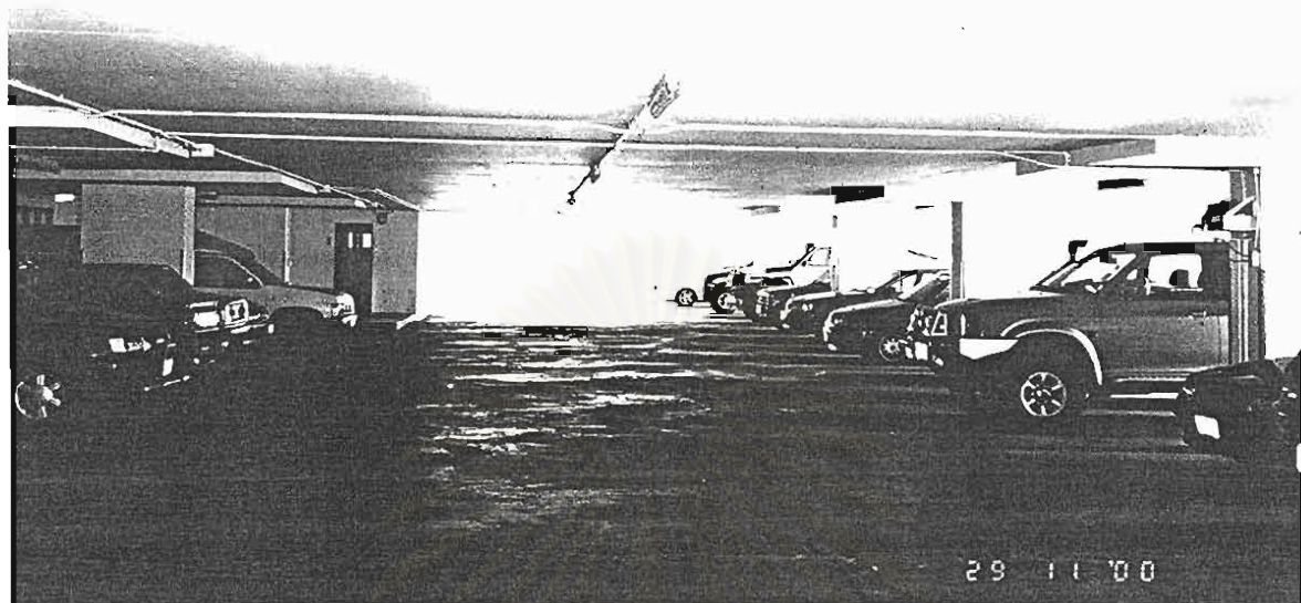
รูปที่ 3.32 : สภาพที่จอดรถภายในอาคารที่จอดรถของโครงการฯ
