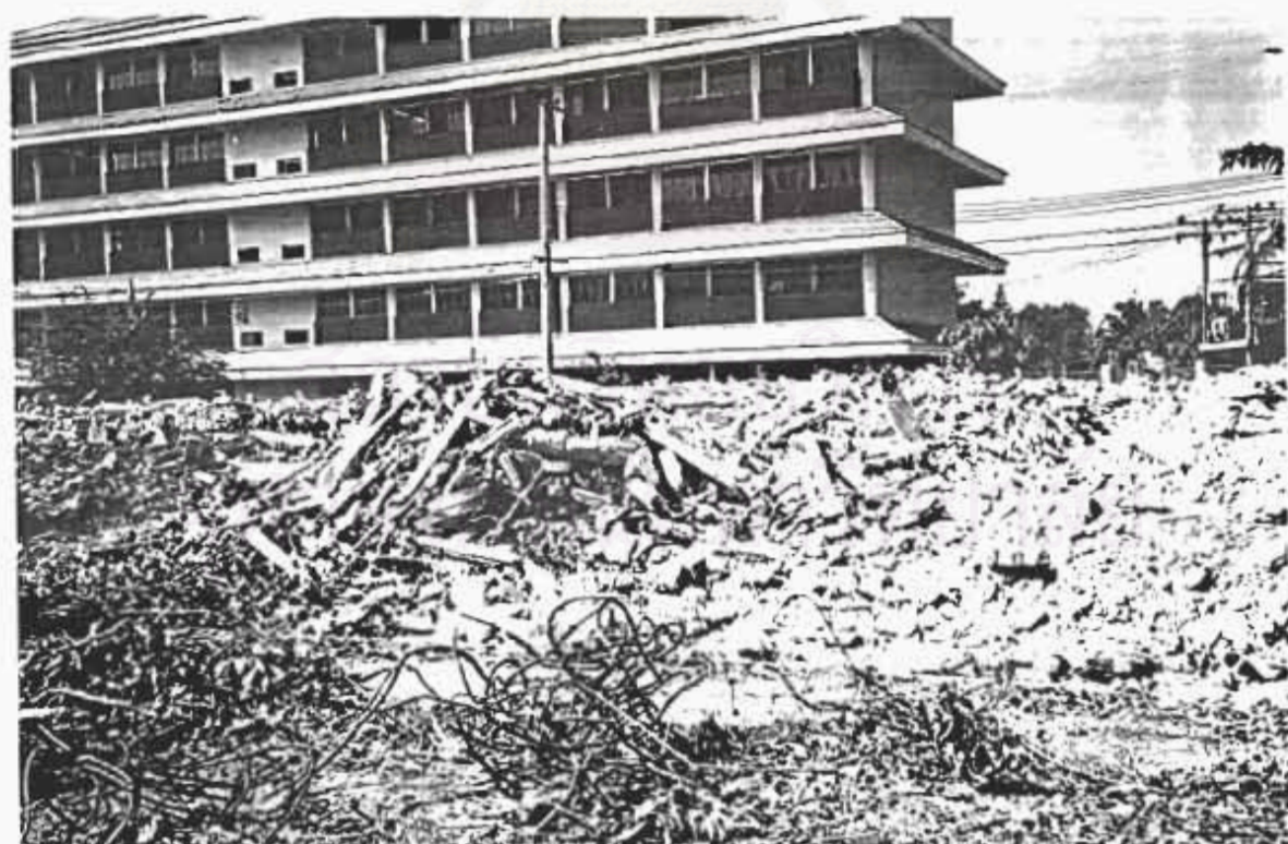
รูปที่ 3.10 : การรื้อถอนอาคารเดิม
