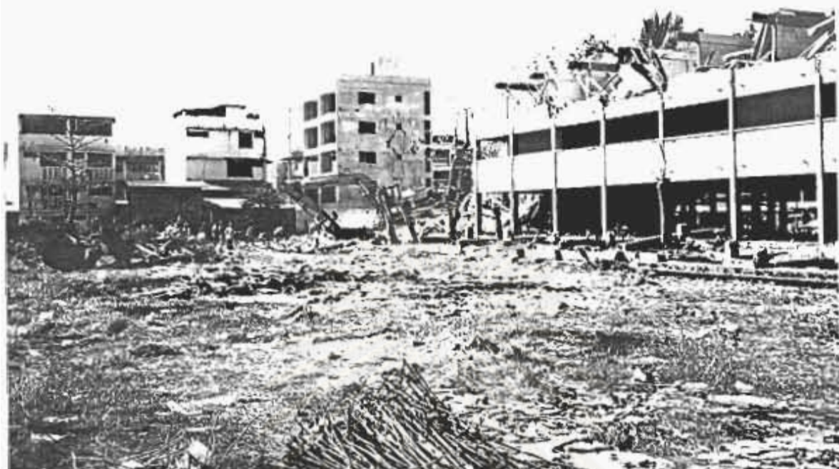
รูปที่ 3.9 : การรื้อถอนอาคารเดิม
