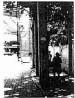
(เสาไฟฟ้า)
