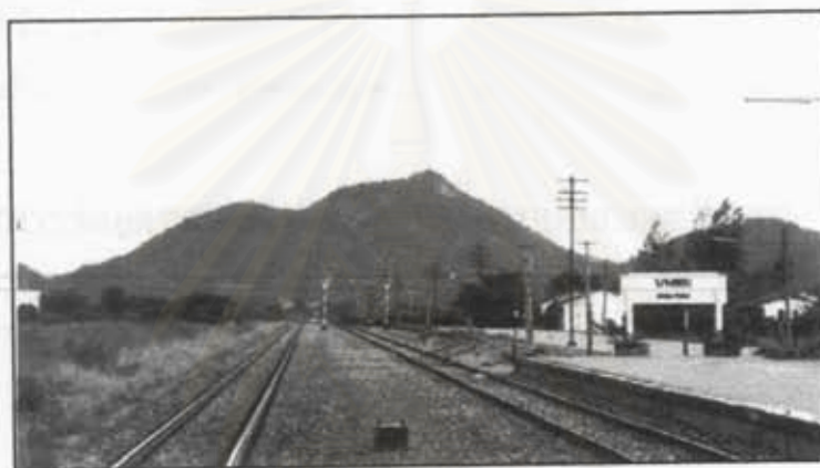
รูปที่ 5-5 สภาพเส้นทางรถไฟสายตะวันออกเฉียงเหนือ บริเวณจังหวัดชลบุรี
