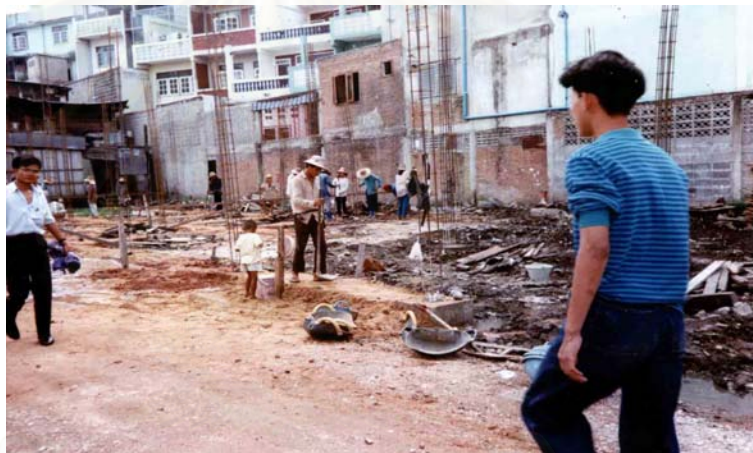
ภาพที่ 32 ช่วงก่อสร้างอาคารพักอาศัย 18 หน่วยแรก (พ.ศ. 2534) ที่มา : สหกรณ์เคหสถานชุมชนเชิงกี จำกัด
