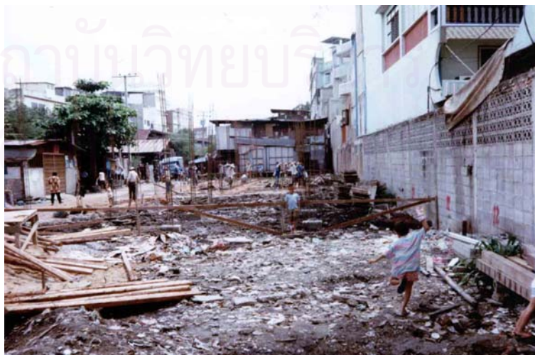
ภาพที่ 30 ขณะก่อสร้างอาคารพักอาศัย 18 หน่วยแรก (พ.ศ. 2534)
