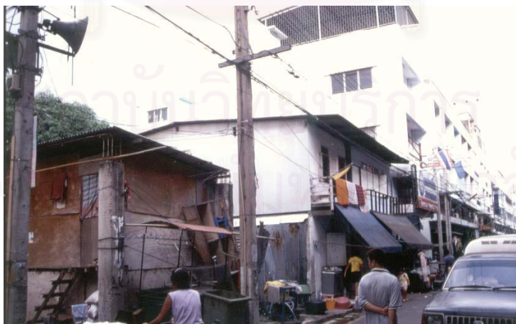
ภาพที่ 39 อาคารในโซนปริมณฑลที่มีความหลากหลายของประเภทของอาคารตั้งแต่สร้างจากเศษวัสดุไปจนถึงอาคาร 4 ชั้น
