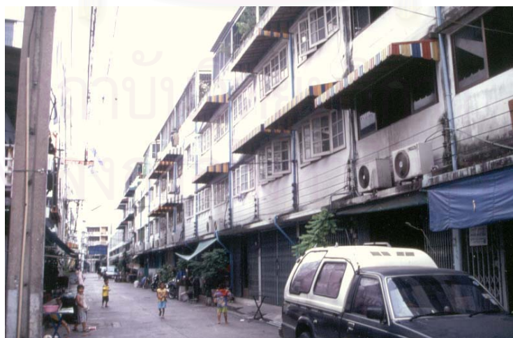
ภาพที่ 36 อาคารโซนเอ 18 หลังที่สร้างเป็นชุดแรก ที่มา : การสำรวจ 5 มีนาคม พ.ศ. 2544
