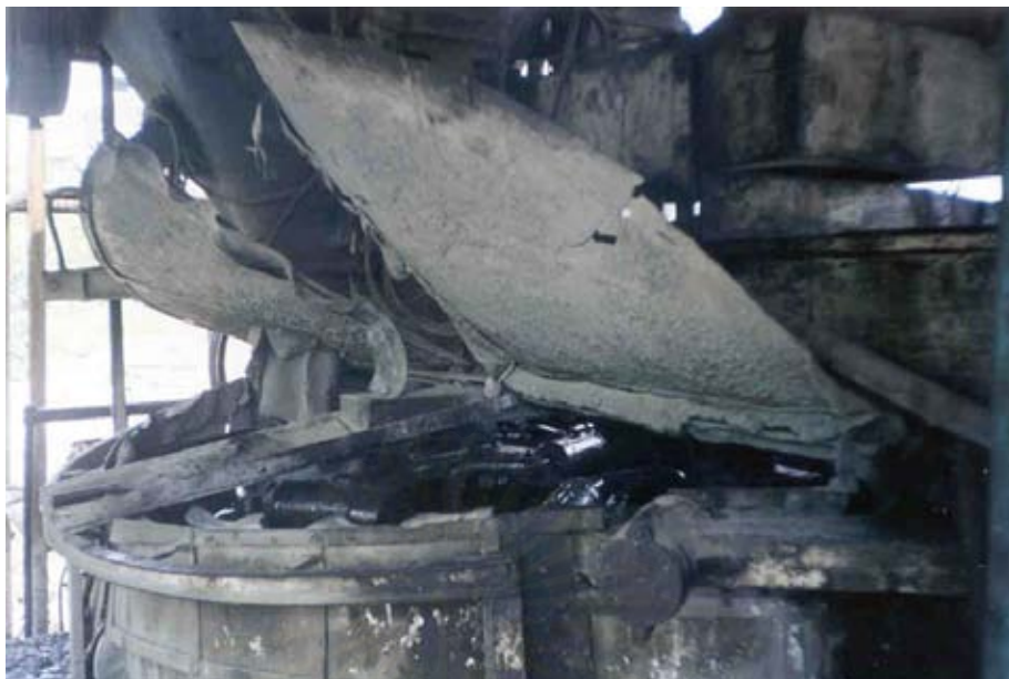
รูปที่ ก6 (a) เครื่องผสมคอนกรีตของโรงงาน ค
