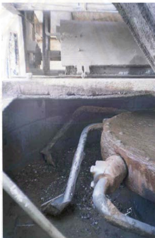
รูปที่ 10 (b) เครื่องผสมคอนกรีตของโรงงาน จ
