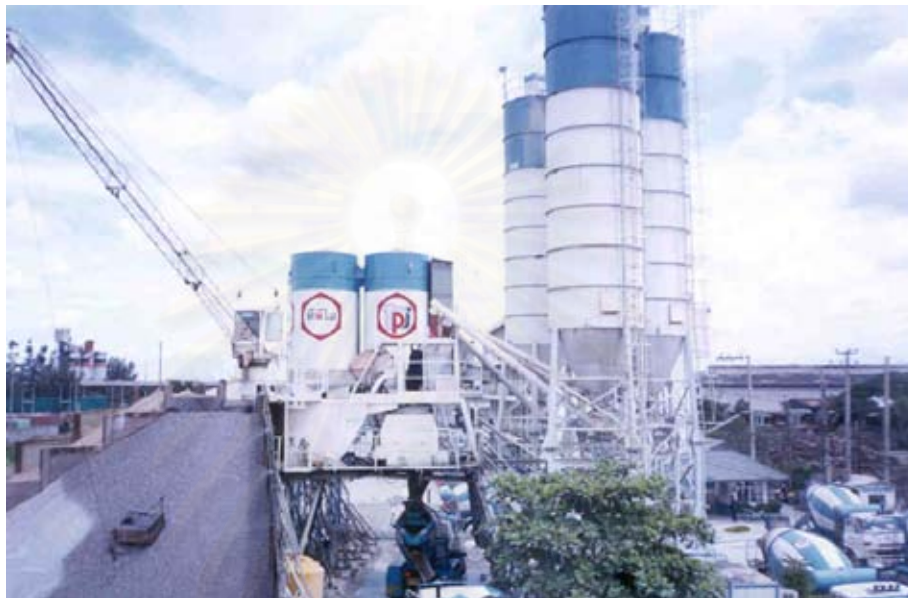
รูปที่ ก1 โรงงาน ก
