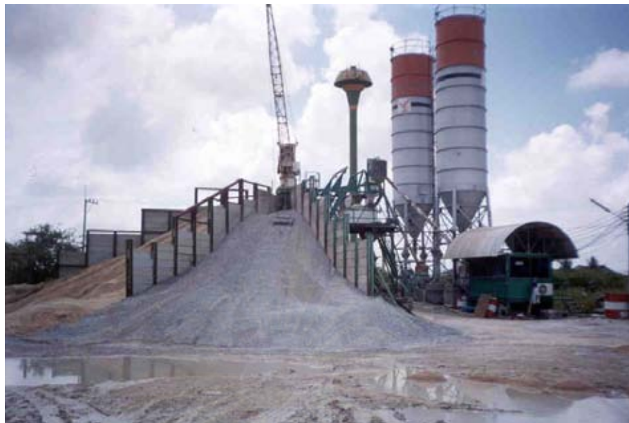
รูปที่ ก7 (a) โรงงาน ง
