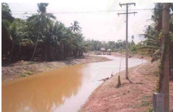
รูปที่ 3 โครงการชลประทาน ขุดลอกคลอง
