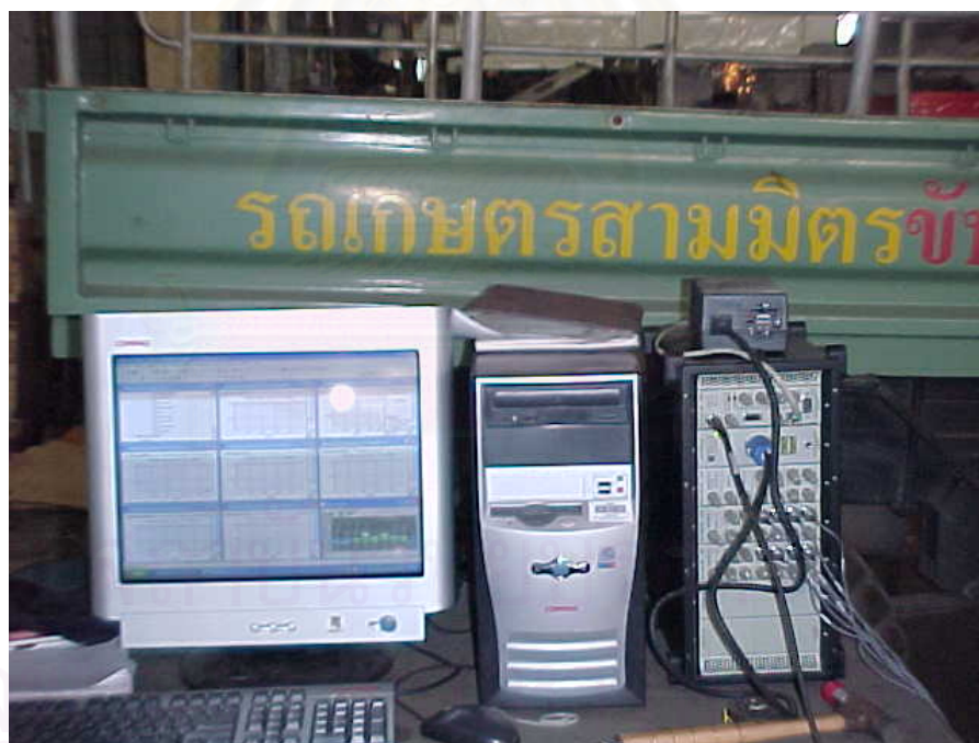
รูปที่ 1. ค. การติดตั้งเครื่อง Pulse analyzer
