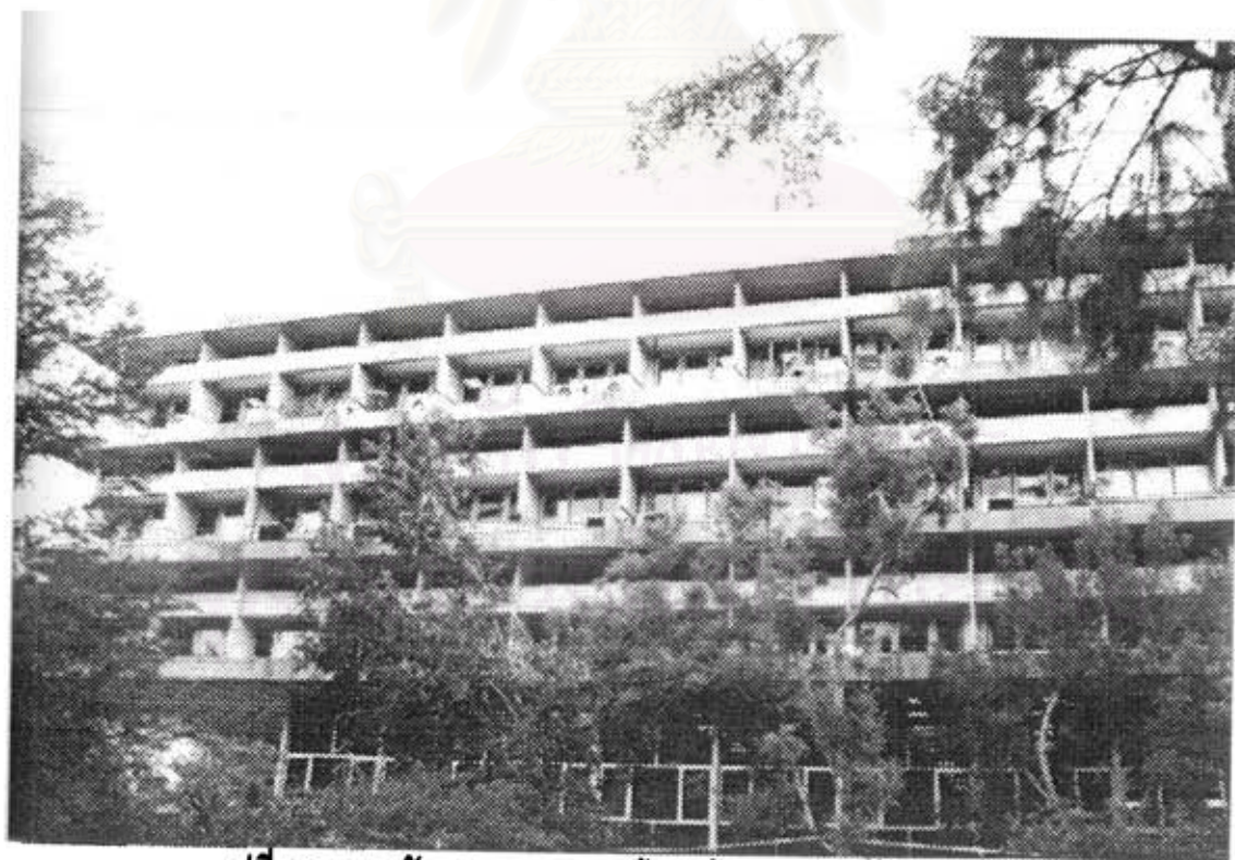
รูปที่ 4.2 แสดงลักษณะ และสภาพด้านหน้าอาคารวิสิทธิ์ ประจวบเหมาะ
