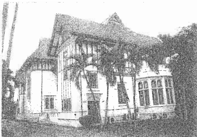
รูปที่ 4-33 สภาพภายนอกอาคารด้านทิศตะวันออกเฉียงใต้
