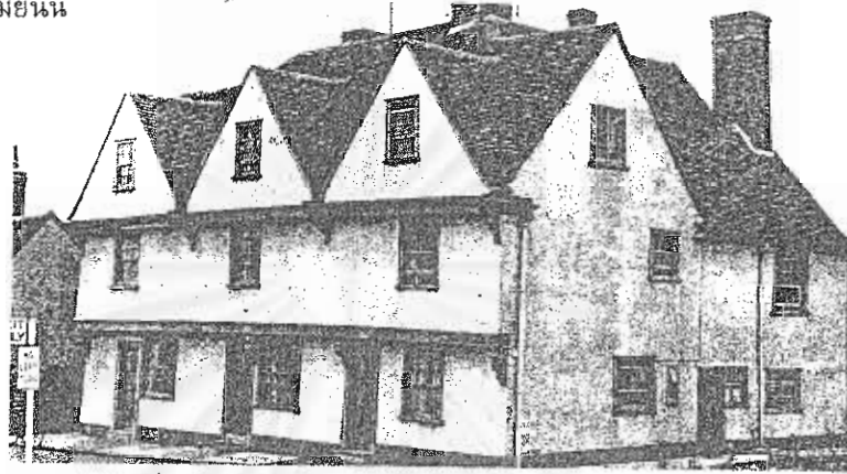
รูปที่ 2-15 ลักษณะผนังอาคารแบบ Plaster and Pargetting ที่มา : Brunskill (1970: 64)
