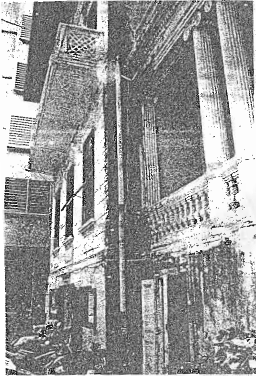
ความชื้นเกิดจากรางน้ำฝนที่รั่วหรือตัน
