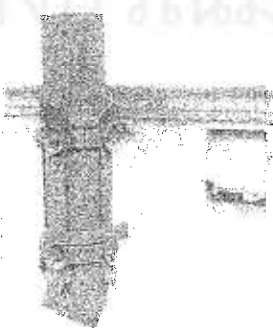
รูปที่ 4-154 การระบายน้ำจากรางน้ำหลังคาที่ไม่มีอุปกรณ์รองรับ ทำให้เกิดความชื้นและคราบตะไคร่น้ำตามขอบอาคาร
