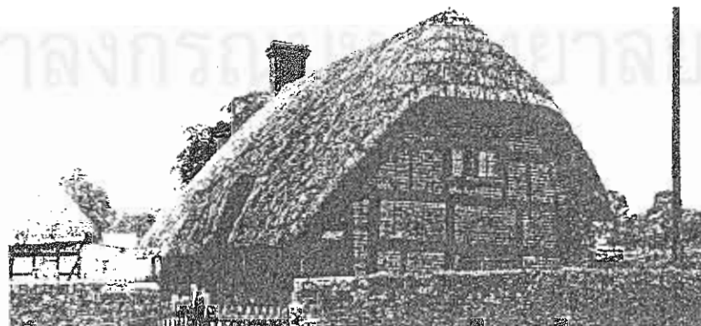
รูปที่ 2-16 ลักษณะผนังอาคารแบบ Brick Noggging ที่มา : Brunskill (1970: 68)
