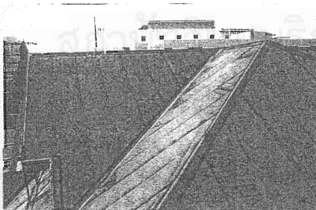
รูปที่ 5-8 การซ่อมขยายรางน้ำวงพญาไท ที่มา : วิภาดา ซาตินันท์, สำรวจ, ต.ค. 2542
