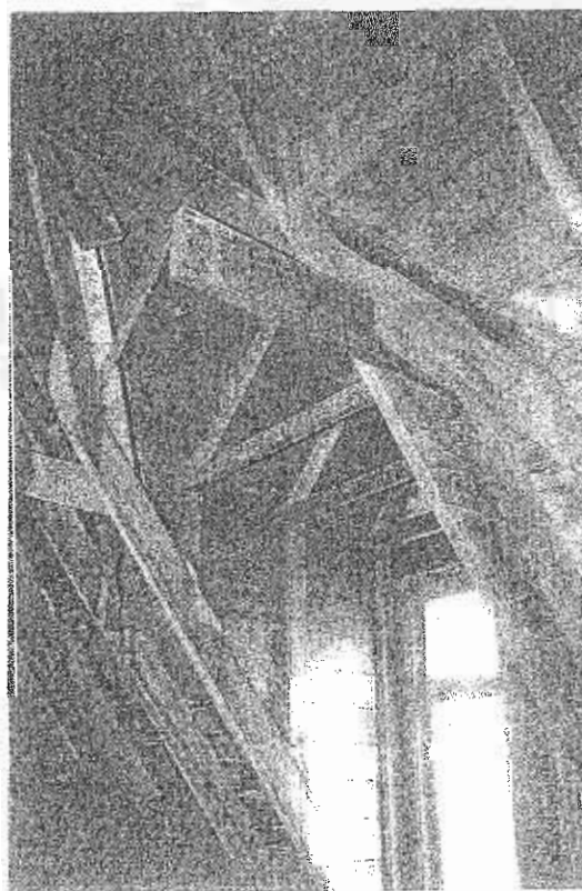
รูปที่ 4-126 การซ่อมโครงสร้างหลังคาโดยใช้ชัน
