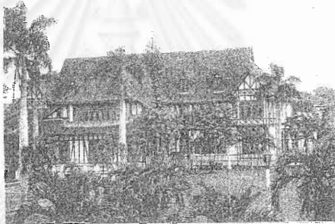
รูปที่ 4-29 สภาพภายนอกอาคารด้านทิศเหนือ
