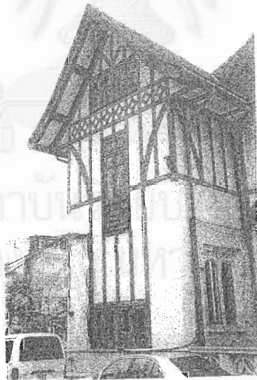
รูปที่ 4-37 ผนังภายนอกอาคารด้านทิศใต้ ก่ออิฐขัดและฉาบปูนและใช้รั้วไม้ประดับอาคาร
