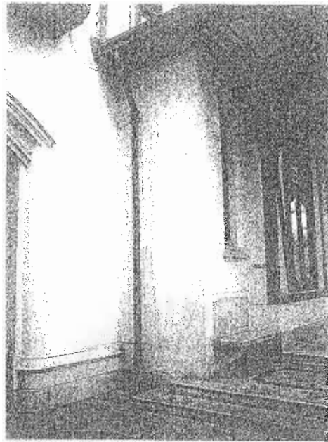
รูปที่ 4-156 ครอบหน้าต่างผนัง เนื่องจากการแตกตัวของรางน้ำ
