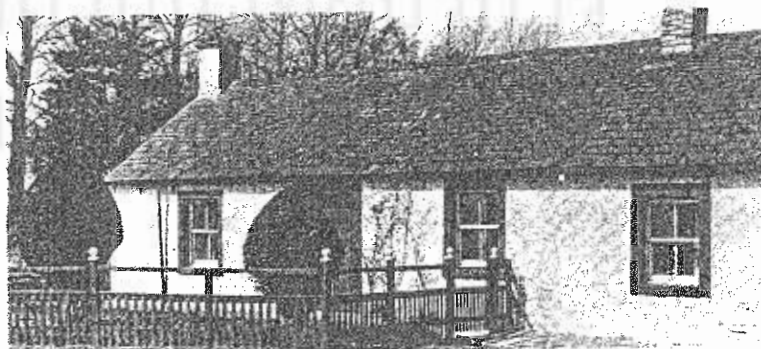
รูปที่ 2-24 ลักษณะหลังคาที่มุงด้วย Slate ที่มา : Brunskill (1970: 82)
