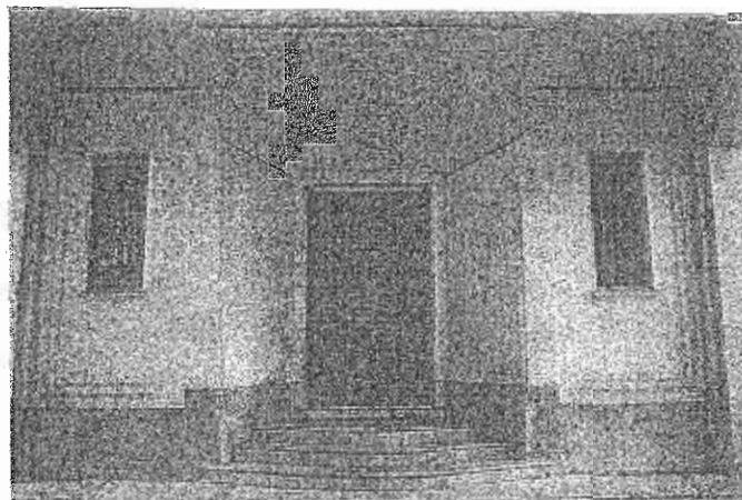
รูปที่ 4-40 ทางเข้าหลักด้านหน้าอาคาร
