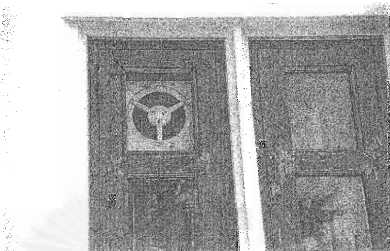
รูปที่ 4-183 สภาพภายนอกของการติดตั้งพัดลมระบายอากาศที่ปิดช่องแสงอาคาร
