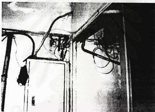
ภาพที่ 4.7 แสดงงานระบบไฟฟ้าในอาคารที่ไม่ได้รับการดูแล
