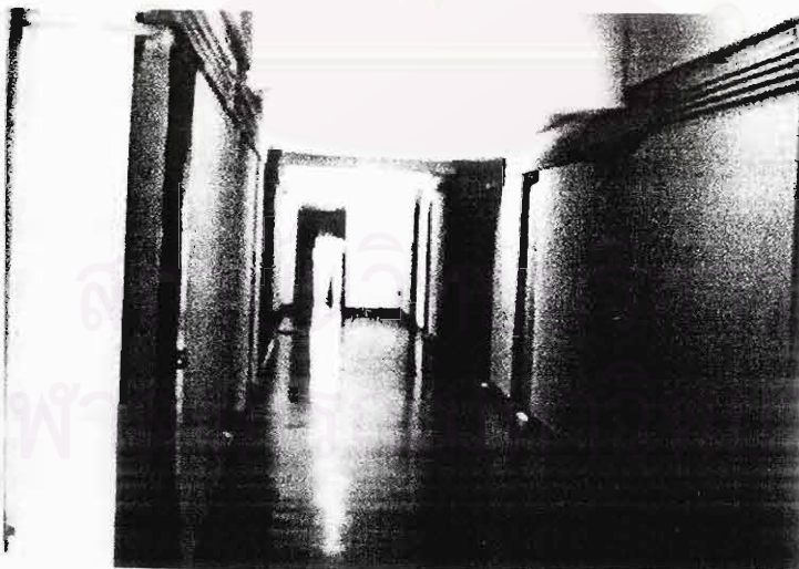
ภาพที่ 4.33 แสดงบริเวณโถงทางเดินกลางอาคารรอยัล ปาร์ค
