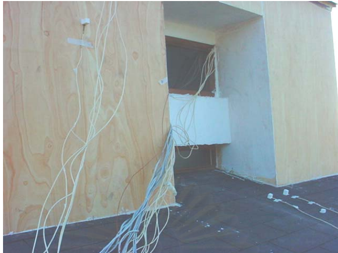
ภาพที่ 5.16 แสดงการเชื่อมต่อ Sensor กับอุปกรณ์ประมวลผล
