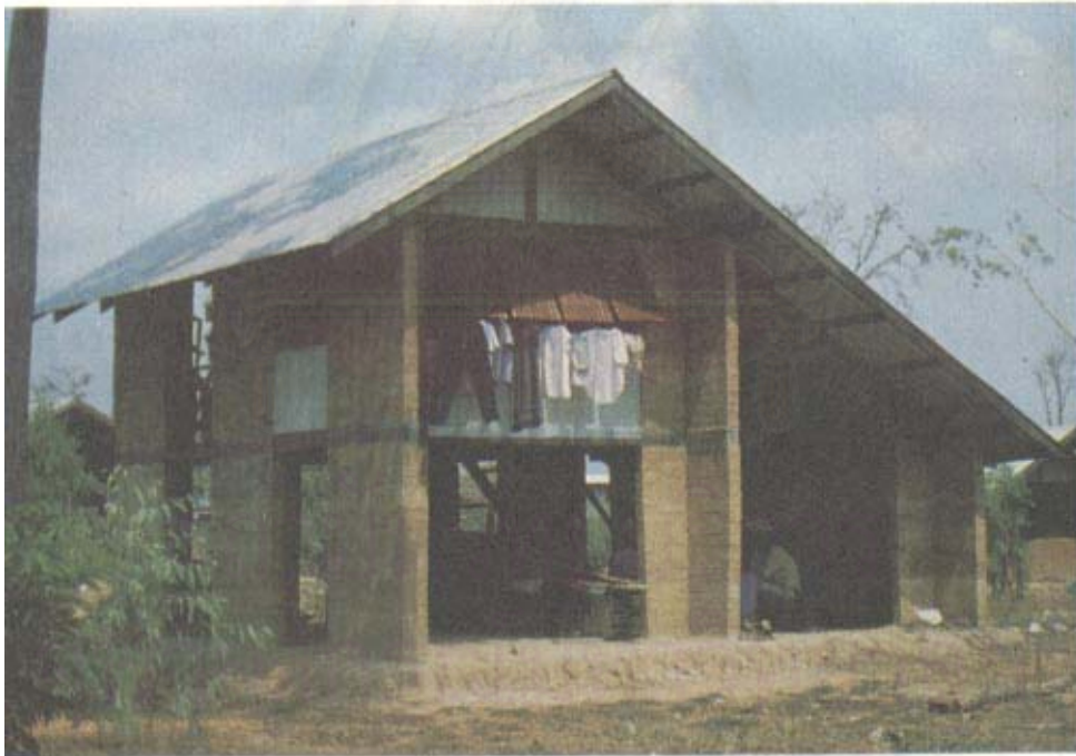
บ้านสองชั้น สร้างด้วยอิฐดินซีเมนต์
