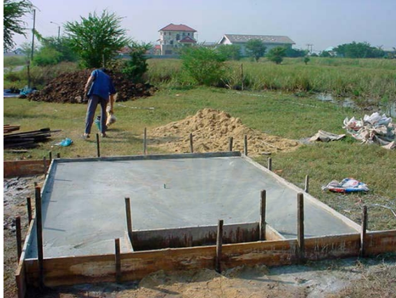
ภาพที่ 5.4 แสดงการก่อสร้างส่วนพื้นอาคาร
