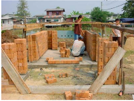
ภาพที่ 5.7 แสดงการก่อสร้างผนังอาคารด้านบน
