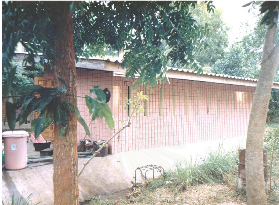
ภาพที่ 2.9 ตัวอย่างอาคารก่อสร้างด้วยอิฐดินซีเมนต์
