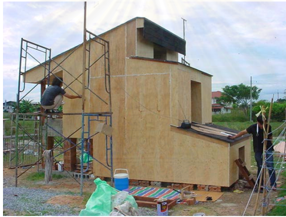
ภาพที่ 5.14 แสดงการทำผิวผนังด้านนอกด้วย แล็กเกอร์เพื่อรักษาสภาพไม้อัด
