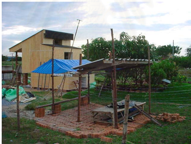
ภาพที่ 5.17 แสดงอาคารทดสอบที่พร้อมทำการวัดผล และอาคารชั่วคราวเพื่อเก็บอุปกรณ์ประมวลผลข้อมูล
