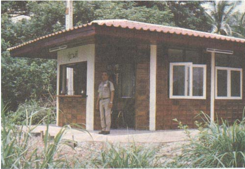
ป้อมยามตำรวจ สร้างด้วยอิฐดินซีเมนต์ จ.กำแพงเพชร
