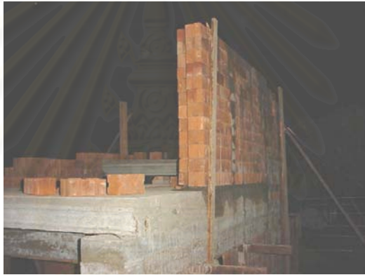
ภาพที่ 5.8 แสดงการก่อสร้างผนังชั้นบนของอาคาร ทดสอบ
