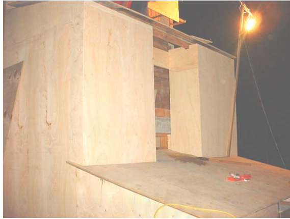
ภาพที่ 5.13 แสดงสภาพผนังภายนอกอาคาร
