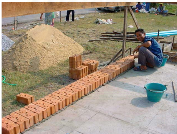
ภาพที่ 5.5 แสดงการก่อสร้างผนังส่วนล่างอาคารทดสอบ
