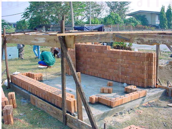
ภาพที่ 5.6 แสดงการก่อสร้างผนังชั้นล่างอาคาร
