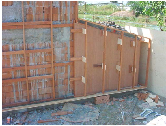
ภาพที่ 5.10 แสดงการก่อสร้างผนังในส่วนที่จะ บรรจุวัสดุฉนวนธรรมชาติ
