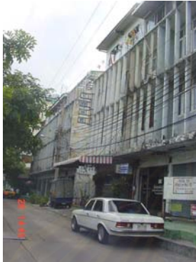
ภาพ 3-27 สภาพแวดล้อมด้านรูปแบบและวัสดุอาคาร กลุ่มอาคารตึกแถว ซอยราชวิถี 3
