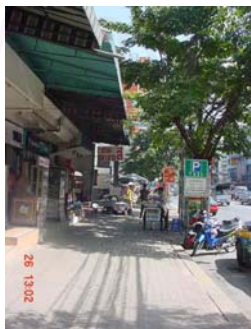
วัสดุปูพื้นคอนกรีตบล็อกสำเร็จรูปสี่เหลี่ยม สลับกับคอนกรีตบล็อกสำเร็จรูปสี่เหลี่ยม (สำหรับคนพิการ) ปูบริเวณทางเดินเท้าริมถนนหลัก
