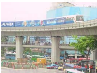
ทางเดินเท้ายกระดับ ใต้โครงสร้างรถไฟฟ้า
