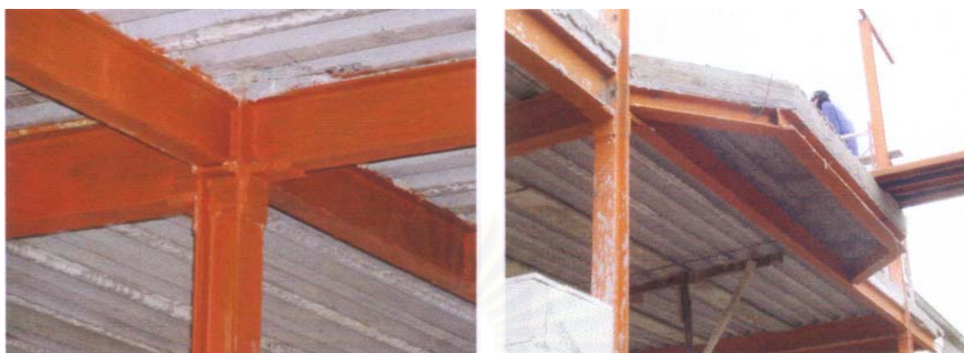
ภาพที่ 5-9 (ซ้าย) - แสดงการวางแผ่นพื้นคอนกรีตสำเร็จรูปชั้นบน และเทคอนกรีตทับหน้า (ขวา) - แสดงการก่อสร้างโครงสร้างพื้นในส่วนพื้นระเบียงที่ยื่นออกมา
