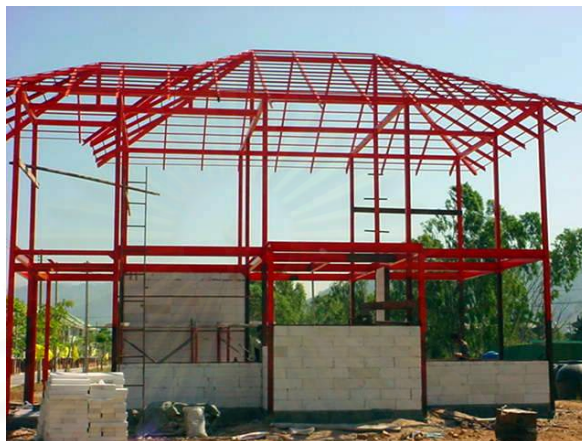
ภาพที่ 5-13 แสดงขั้นตอนการก่อสร้างงานโครงสร้างหลังคาเหล็ก
