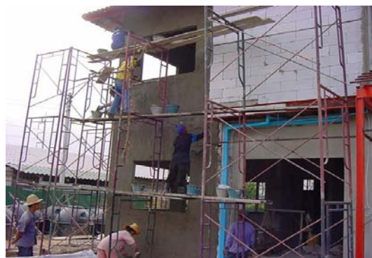
ภาพที่ 5-21 แสดงชิ้นงานฉาบผนังบล็อกคอนกรีตมวลเบา
