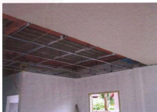
ภาพที่ 5-23 แสดงการติดตั้งงานฝ้าเพดาน
