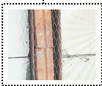
ภาพที่ 5-21 แสดงชิ้นงานฉาบผนังบล็อกคอนกรีตมวลเบา
