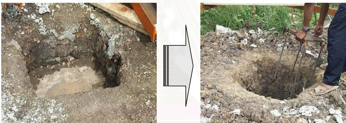
ภาพที่ 5-1 แสดงขั้นตอนการก่อสร้างงานระบบฐานรากของบ้านโครงสร้างเหล็ก
