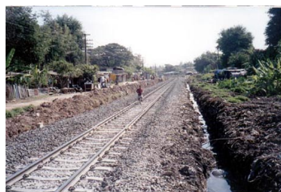
การรถไฟฯ ชุดร่องทำรางระบายน้ำริมทางรถไฟ
