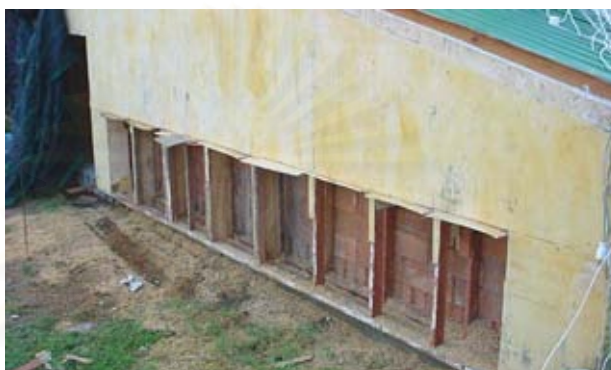
ภาพที่ 5-12 แสดงการเตรียมผนังโดยเอาฉนวนผนังออกเพื่อการใช้ประโยชน์จากผิวสัมผัสผืนดิน
