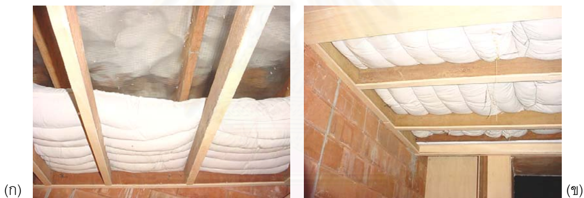
ภาพที่ 4-60 (ก)และ(ข) แสดงการติดตั้งฉนวนฝ้าเพดาน ใช้เกลบที่บรรจุใส่ในถุงผ้า
