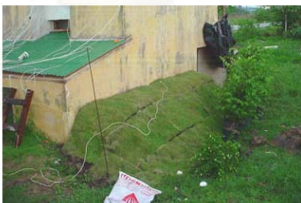
ภาพที่ 5-13 แสดงการถมดินให้สัมผัสผืนผนังของอาคารทดลองชั้นล่างสูงจากพื้นอาคาร 0.60 เมตร และใช้หญ้าเป็นพืชคลุมดินเพื่อลดความร้อนที่ผืนดิน และใช้ต้นไม้ขนาดเล็กให้ร่มเงากับผืนดิน
