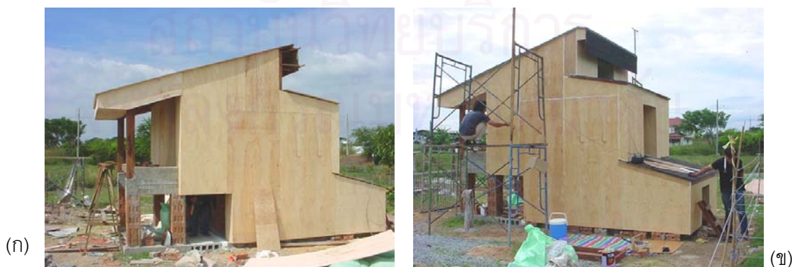
ภาพที่ 4-61 (ก)และ(ข) แสดงภาพอาคารทดลองที่ก่อสร้างแล้วเสร็จ
