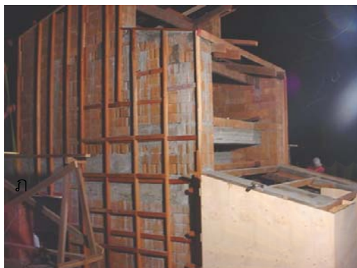
ภาพที่ 4-56 (ก) แสดงขั้นตอนการก่อสร้างผนังส่วนที่เป็นฉนวน โดยทำเป็นกล่องเพื่อใส่แกลบ (ข) แสดงการบรรจุแกลบลงไปในกลุ่มไม้ัดเพื่อทำหน้าที่เป็นผนังฉนวน
