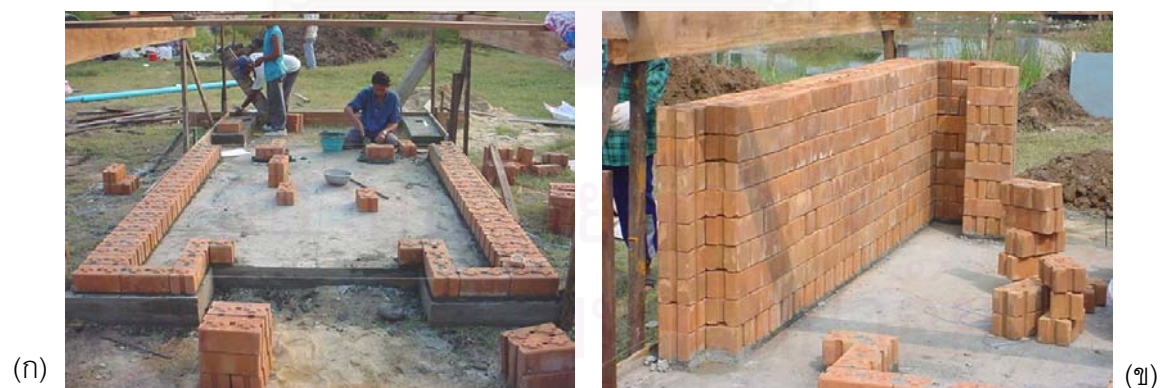
ภาพที่ 4-52 (ก)และ(ข) แสดงขั้นตอนการก่อผนังอิฐดินซีเมนต์ เพื่อเป็นผนังห้องชั้นล่างของอาคารทดลอง
