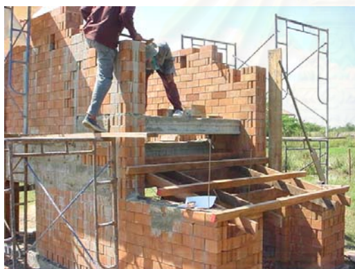
ภาพที่ 4-57 (ก) แสดงการก่อสร้างโครงหลังคาด้านทิศเหนือของห้องชั้นล่าง (ข) แสดงการก่อสร้างโครงหลังคาของห้องชั้นบน
