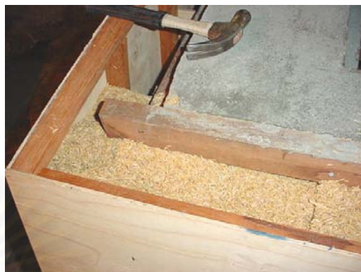
ภาพที่ 4-56 (ก) แสดงขั้นตอนการก่อสร้างผนังส่วนที่เป็นฉนวน โดยทำเป็นกล่องเพื่อใส่แกลบ (ข) แสดงการบรรจุแกลบลงไปในกลุ่มไม้ัดเพื่อทำหน้าที่เป็นผนังฉนวน
