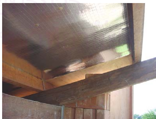
ภาพที่ 4-58 (ก) แสดงการปูแผ่นพอยดีใต้แผ่นไม้ัดเพื่อใช้มุงหลังคา (ข) แสดงการมุงแผ่นไม้ัดบนโครงหลังคา โดยให้ด้านที่มีแผ่นพอยดีอยู่ด้านล่าง
