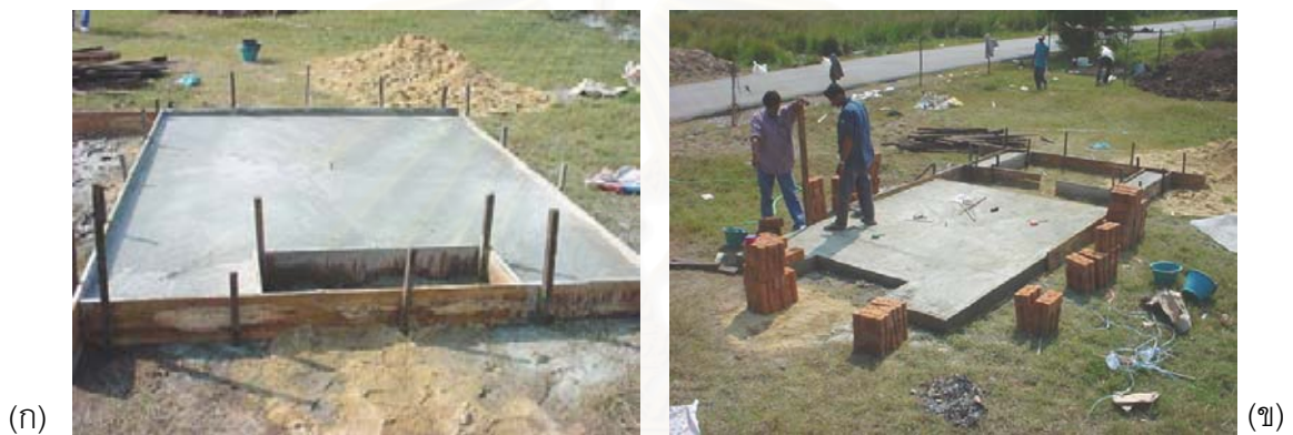
ภาพที่ 4-51 (ก)และ(ข) แสดงขั้นตอนการก่อสร้างพื้น ค.ส.ล. ชั้นล่างของอาคารทดลอง
