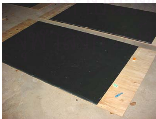
ภาพที่ 4-58 (ก) แสดงการปูแผ่นพอยดีใต้แผ่นไม้ัดเพื่อใช้มุงหลังคา (ข) แสดงการมุงแผ่นไม้ัดบนโครงหลังคา โดยให้ด้านที่มีแผ่นพอยดีอยู่ด้านล่าง
