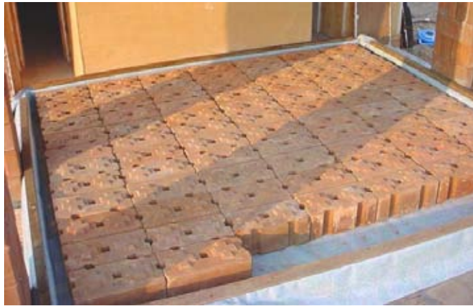
ภาพที่ 5-7 แสดงพื้นผิวของวัสดุปูพื้น ที่มีการซีมน้ำตลอดเวลา เพื่อให้ความ เย็นจากการระเหยของน้ำที่ผิววัสดุ
