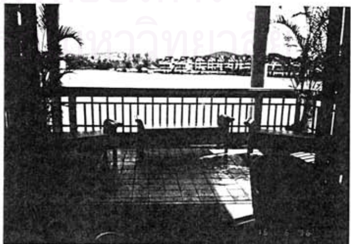
รูปที่ 3.57 แสดงลูกกรงระเบียงแบบ แนวตั้งและแนวนอน
