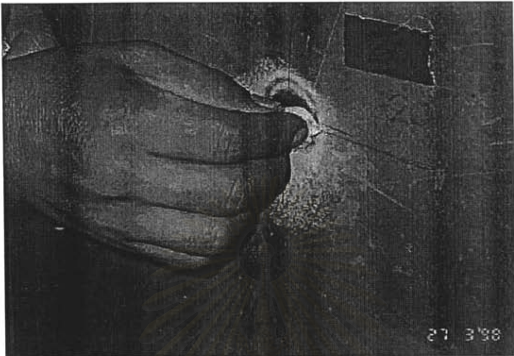
รูปที่ 3-11 แสดงการทำความสะอาดบริเวณที่จะทำการติดตั้งเดรนเกจ ต่อจากขั้นตอนการขัดสี
