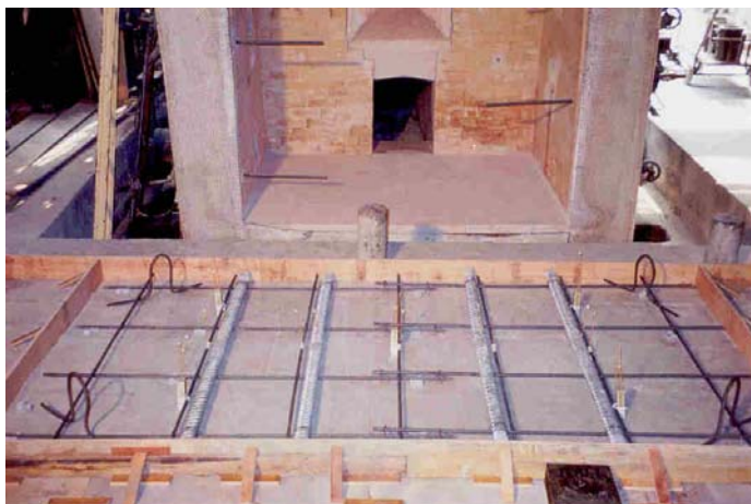
รูปที่ 3.10 แบบหล่อคอนกรีตสำหรับแผ่นพื้นที่ 2 (เพิ่มระยะหุ้มท่อร้อยลวดเหล็กยัดแรง)
