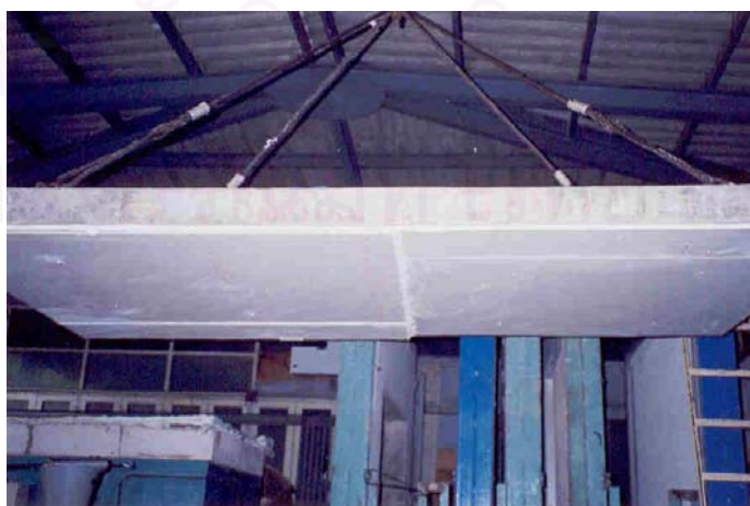
รูปที่ 3.15 แผ่นพื้นที่ 3 ที่ติดตั้งแผ่นยิปซัมเสร็จสมบูรณ์แล้ว
