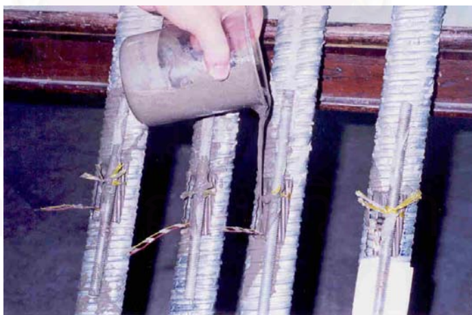
รูปที่ 3.6 วิธีการเติมวัสดุเกราที่ลงในท่อร้อยลวดเกลียวอัดแรง
