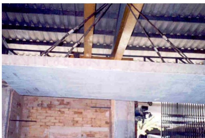
รูปที่ 3.18 แผ่นพื้นที่ 4 ที่ทาสีทนไฟเสร็จสมบูรณ์แล้ว
