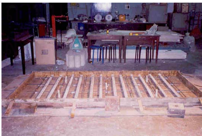
รูปที่ 3.12 แบบหล่อคอนกรีตสำหรับตัวอย่างแผ่นพื้นที่ 5 (ปรับปรุงวัสดุเกรทท์)
