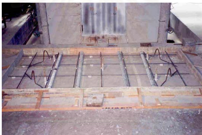
รูปที่ 3.17 แบบหล่อคอนกรีตสำหรับแผ่นพื้นที่ 4 (ทาสีทนไฟที่ผิวล่างของแผ่นพื้น)
