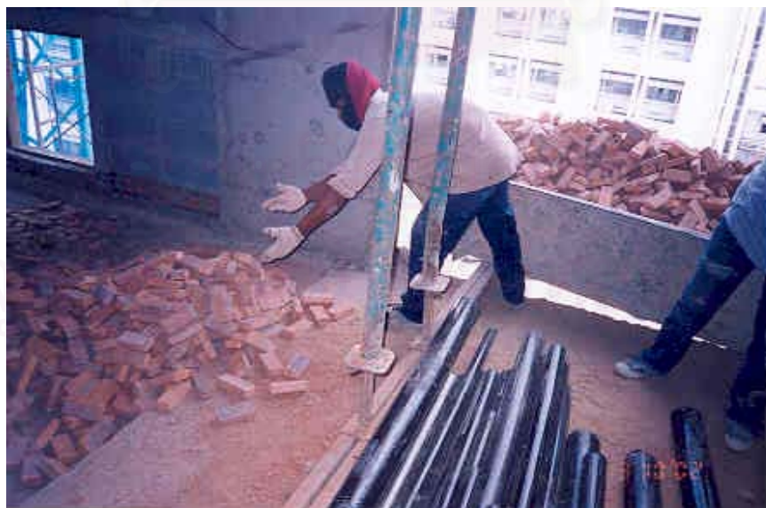
รูปที่ 4.3 ความเสียหายของอิฐมอญเนื่องจากการขาดความระมัดระวังในการขนย้าย
