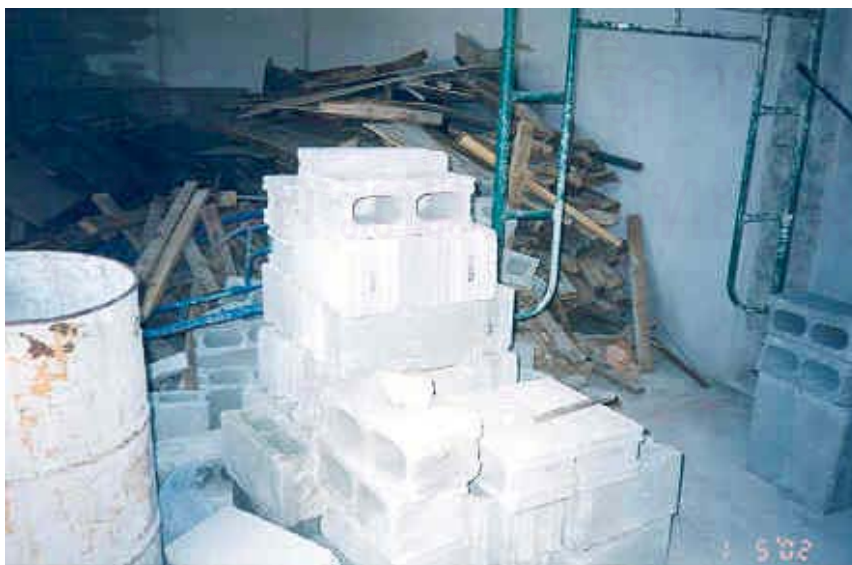
รูปที่ 4.19 การเก็บวัสดุที่ไม่เป็นระเบียบ และหลายวัสดุใกล้กัน
