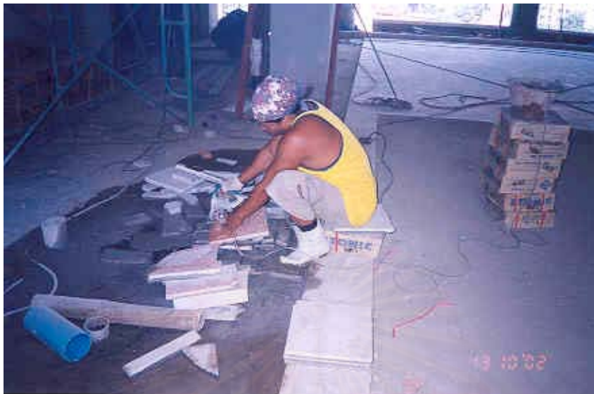
รูปที่ 4.13 การตัดเพื่อให้ได้ขนาดทำให้เกิดความสูญเสียของกระเบื้องหินขัดสำเร็จรูป
