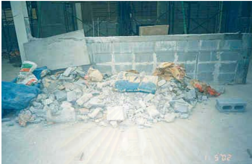
รูปที่ 4.18 ปริมาณความสูญเสียบรรจุภัณฑ์ของคอนกรีตบล็อกเนื่องจากการเปลี่ยนแปลงแก้ไขแบบ ก่อสร้าง
