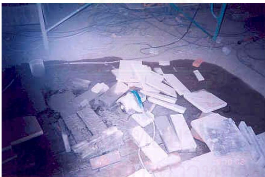
รูปที่ 4.14 ความไม่เป็นระเบียบ และขาดการจัดการที่ดีในการนำเศษเหลือส่วนอื่นมาใช้งาน ทำให้เกิดความสูญเสียของกระเบื้องหินขัดสำเร็จรูป
