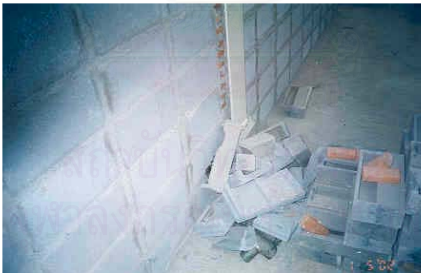
รูปที่ 4.17 ความสูญเสียของคอนกรีตบล็อก เนื่องจากการใช้งาน ควรมีการคัดแยกออกจากวัสดุส่วนอื่นที่ยังใช้งานได้
