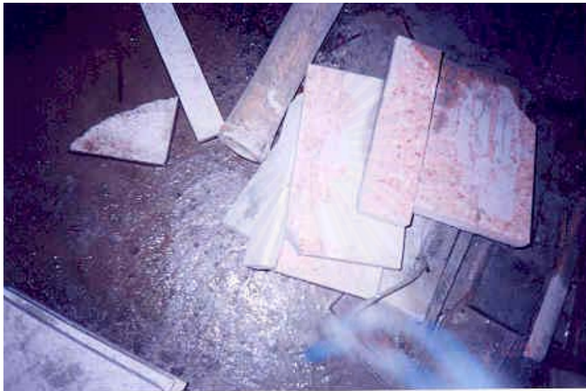
รูปที่ 4.15 ความสูญเสียของกระเบื้องหินขัดสำเร็จรูป เนื่องจากการขาดการเก็บรักษาวัสดุที่เหลือเศษจากการตัดไม่เป็นระเบียบ
