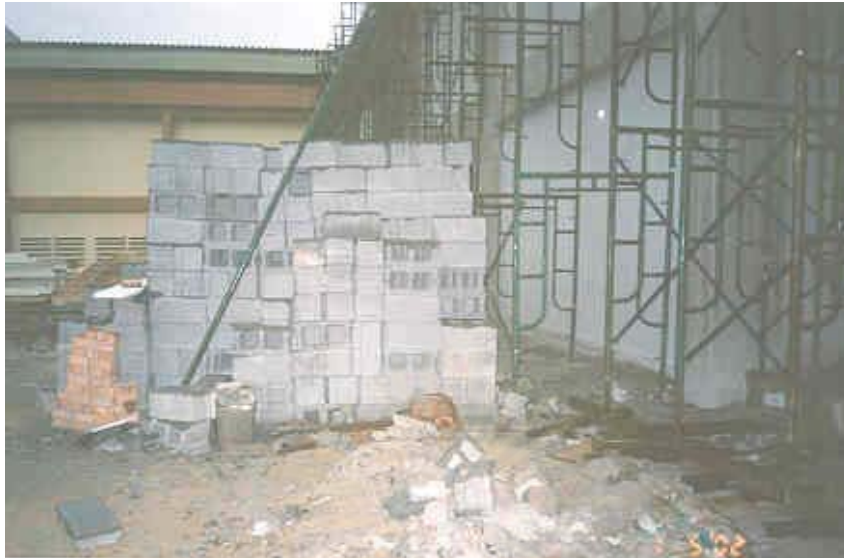
รูปที่ 4.16 การเก็บกองที่สูงเกินไปอาจทำให้เกิดการพังลงมาได้ง่ายทำให้เกิดความเสียหายต่อวัสดุ
