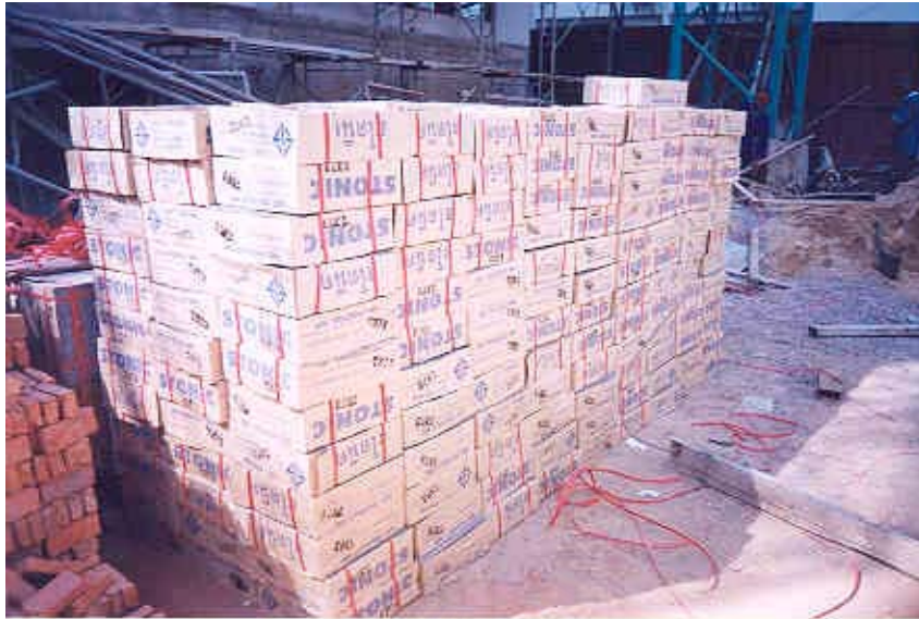
รูปที่ 4.8 การเก็บกองที่เป็นระเบียบช่วยให้ลดความสูญเสียของวัสดุ
