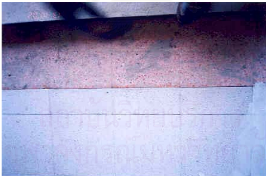
รูปที่ 4.12 ผลของการออกแบบ ทำให้ต้องตัดกระเบื้องหินขัดสำเร็จรูปตามขนาดที่ต้องการ
