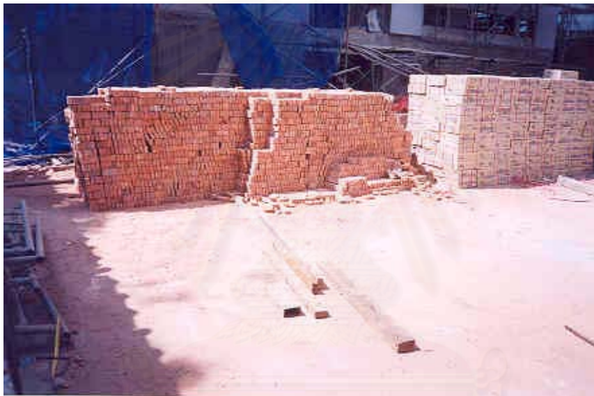
รูปที่ 4.1 การกองเก็บอิฐมอญ บริเวณโครงการก่อสร้าง
