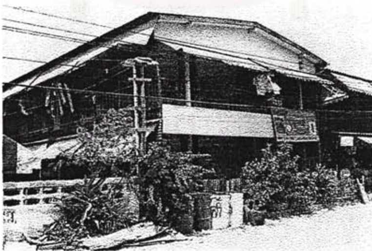
ภาพที่ 10. ลักษณะเป็นเรือนแถวไม้ เปิดเป็นหอพักชายให้เช่า โดยมีป้ายชื่อหอพักติดอยู่ด้านหน้า
