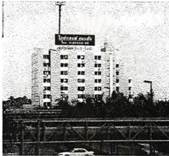
ภาพที่ 19. อพาร์ทเมนต์ให้เช่า ตั้งอยู่ติดกับห้างสรรพสินค้า ในเขตบึงกุ่ม
