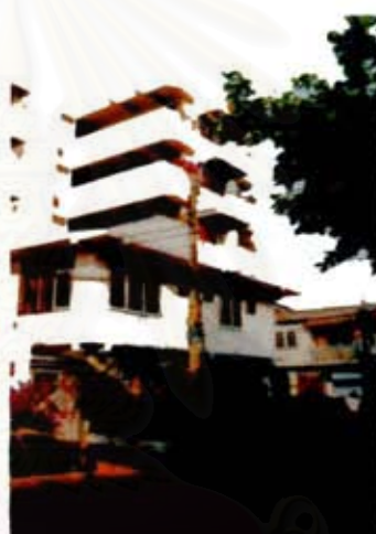
รูปที่ 5-76 อาคารที่ก่อสร้างขึ้นใหม่ เพื่อทำธุรกิจเกสต์เฮ้าส์ แขวงวัดสามพระยา
