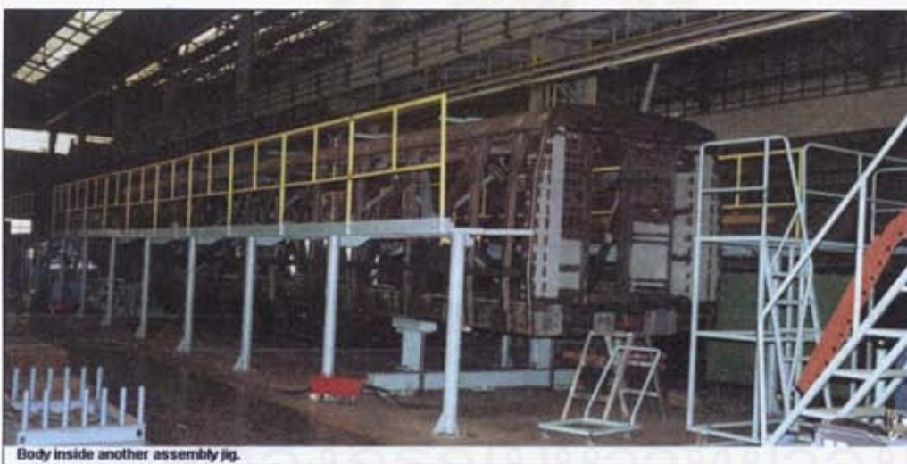
รูปที่ 5.35: การประกอบโครงสร้างต่างๆเข้าด้วยกันเป็นตู้โดยสาร
