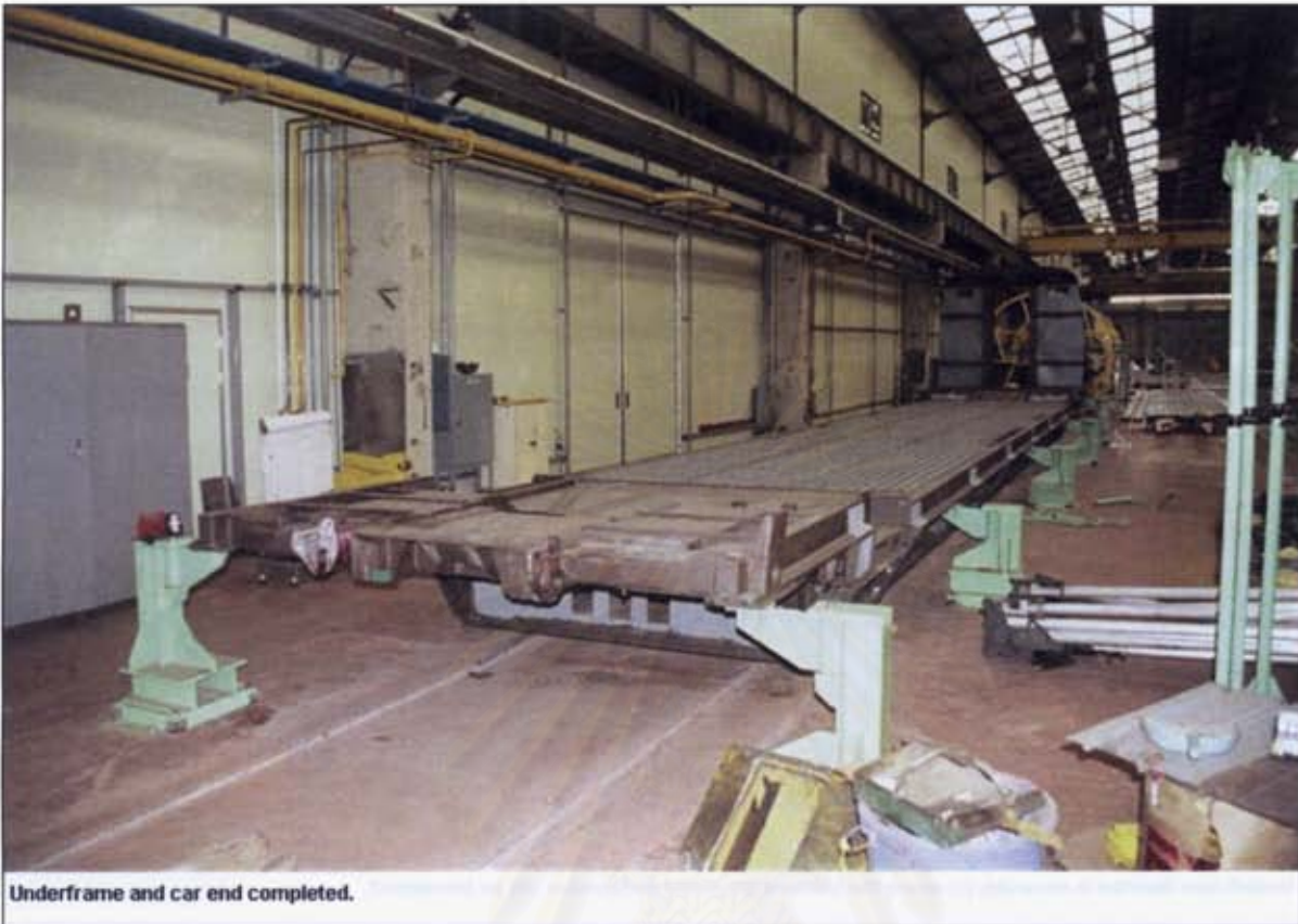
รูปที่ 5.30: โครงสร้างฐาน (underframe) ที่เชื่อมเสร็จแล้ว
