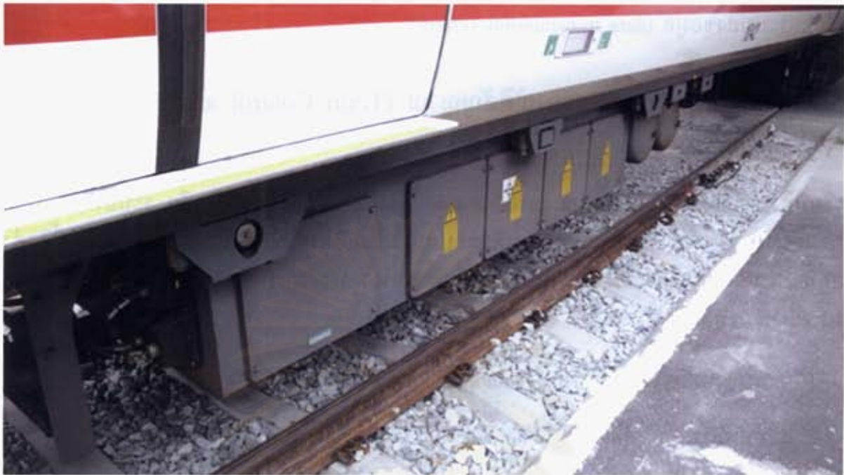
รูปที่ 5.18: electrification and power supply system ด้านล่างของรถ
