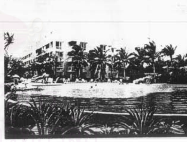
3.19 อาคารสาธารณูปโภค ประเภทคอนโดมิเนียม
