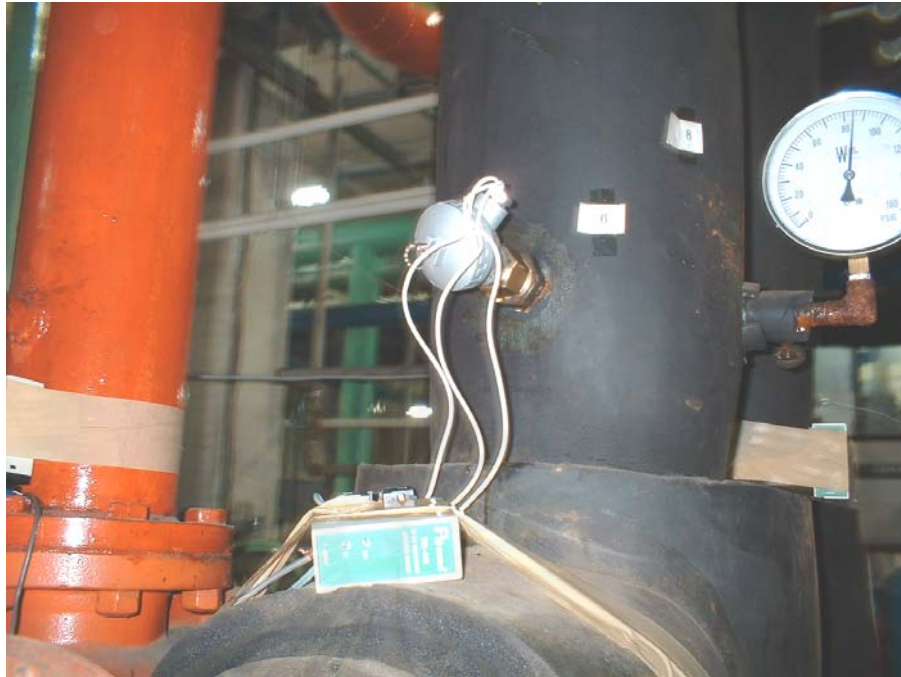
รูปที่ 7.10 การติดตั้ง Pt 100 และเครื่องส่ง
