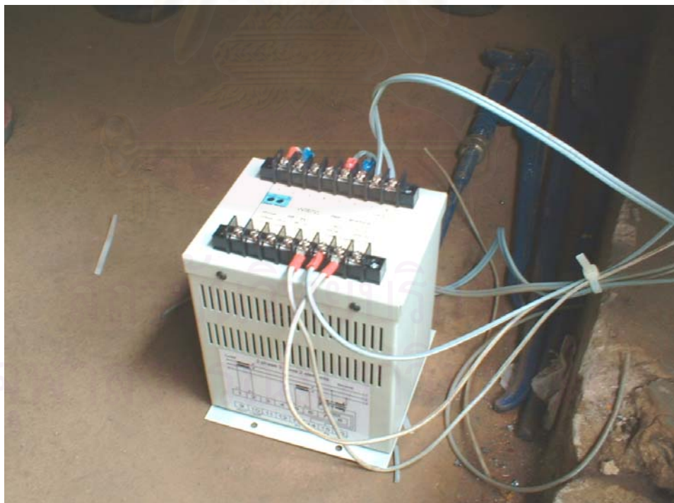
รูปที่ 7.13 การติดตั้งอุปกรณ์วัดกำลังไฟฟ้า
