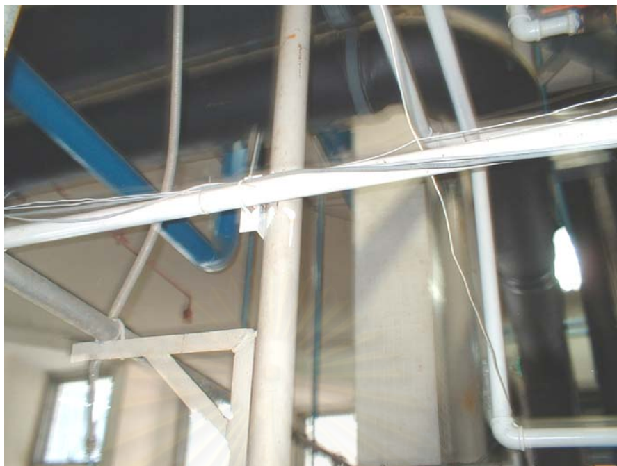
รูปที่ 7.18 การเดินสายนำสัญญาณ
