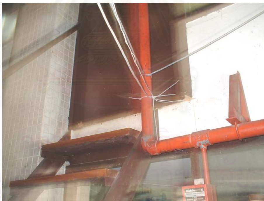
รูปที่ 7.19 การเดินสายนำสัญญาณเข้าห้องควบคุม
