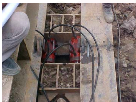
รูปที่ 3.18 Hydraulic Jack และตัวควบคุมที่ใช้ในการอัดแรง
