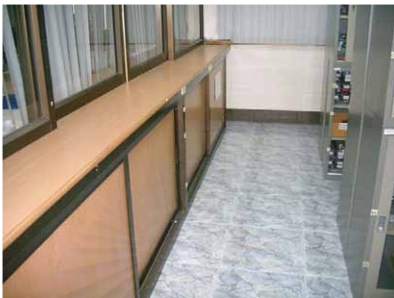
รูปที่ 5.1 บริเวณพื้นที่ทางเดินไม่มีอะไหล่กีดขวาง
