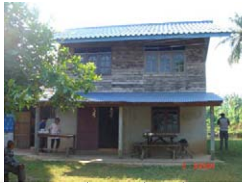
รูปที่ ข บ้านครึ่งอิฐครึ่งไม้
