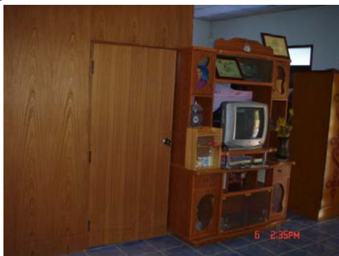
รูปที่ ก กันห้องโดยใช้ไม้อัด
