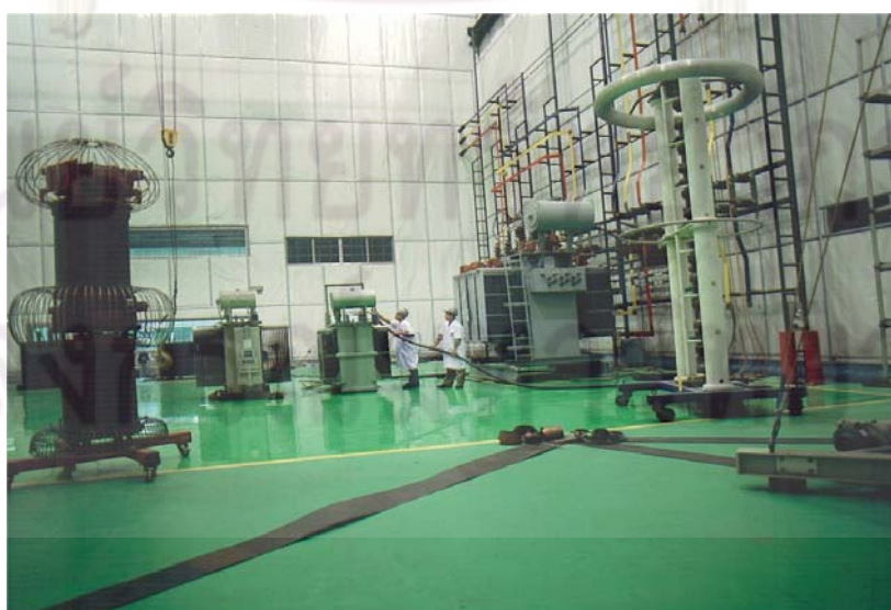
รูปที่ 3.17 : การทดสอบไฟฟ้า
