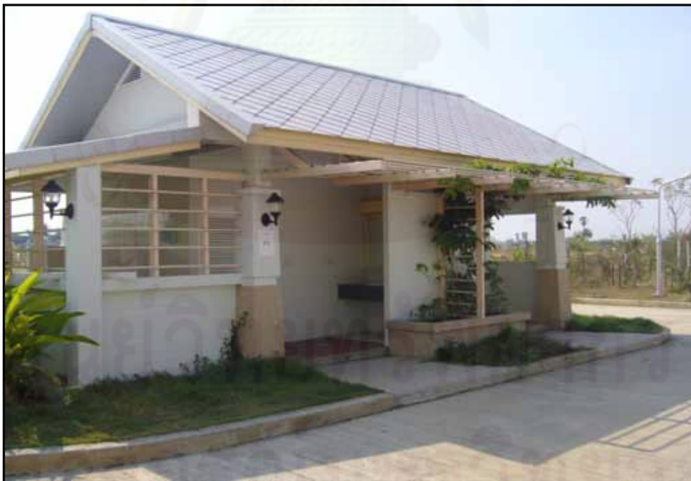
ภาพที่ 2-7 อาคารห้องน้ำสาธารณะ
