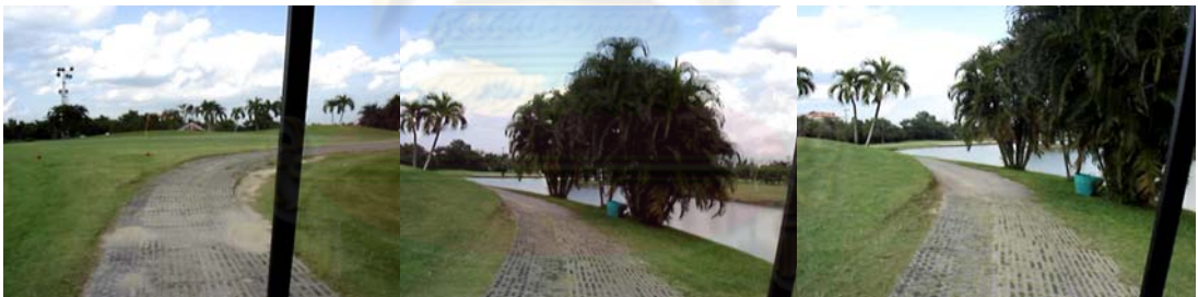
รูปที่ ค-19 แสดงลักษณะถนนในช่วงระยะตั้งแต่ 3100 – 3200 เมตร ของสนามกอล์ฟ ชัมมิท ไพร์ เอิร์ต แอน คันทรี คลับ โซน West
