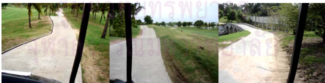
รูปที่ 6-42 ถนนคอนกรีตไม่ได้ลาดยางที่สังเกตคลื่นความถี่ต่ำได้
