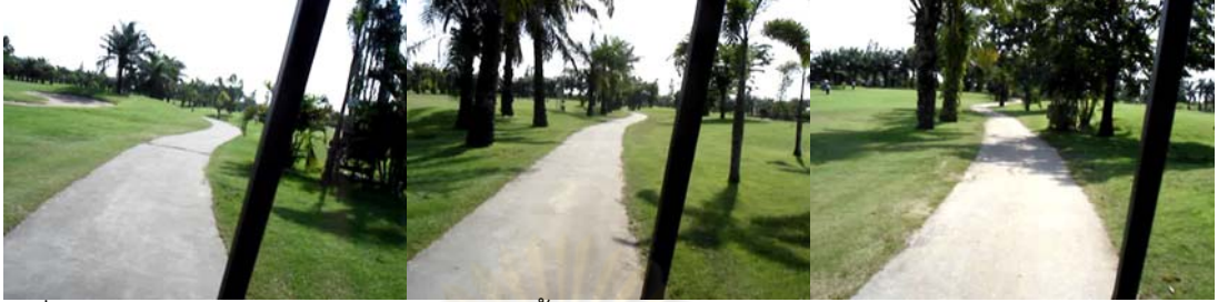
รูปที่ ค-18 แสดงลักษณะถนนในช่วงระยะตั้งแต่ 100 – 3100 เมตร ของสนามกอล์ฟ ชัมมิท ไพร์ เอิร์ต แอน คันทรี คลับ โซน West
