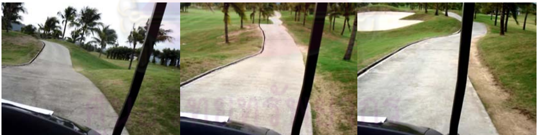
รูปที่ ค-11 แสดงลักษณะถนนในช่วงระยะตั้งแต่ 650 – 850 เมตร ของสนามกอล์ฟ พัฒนา สปอร์ตคลับ โชน B
