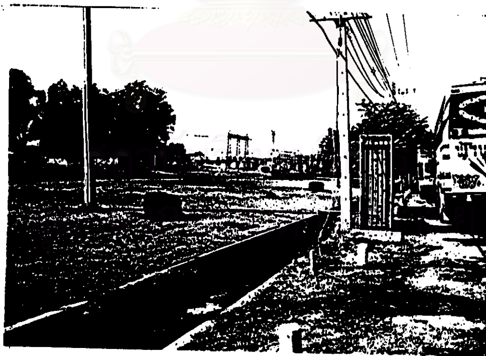
ภาพที่ 14 รางระบายน้ำภายในนิคมฯ. ขนาดกว้าง 2 เมตร ลึก 2 เมตร
