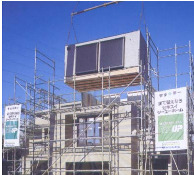
รูปภาพที่ 2.55 แสดงระบบการก่อสร้างอาคารตัวอย่าง ที่มา: จากการสำรวจ
