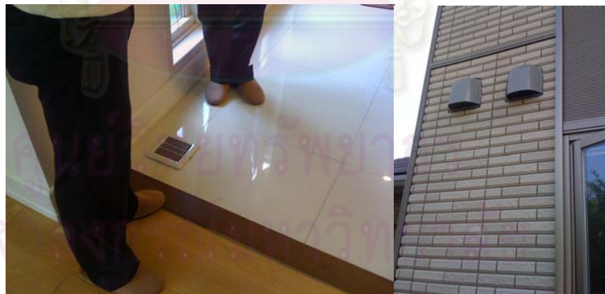
รูปภาพที่ 2.60 แสดงช่องระบายอากาศภายในและภายนอกอาคาร
