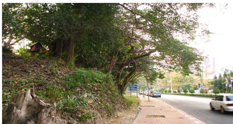
ภาพที่ 5.16 การตัดถนนห้วยแก้วผ่านกลางเวียงเจ็ดลินจากแจ่งหัวรินขึ้นดอยสุเทพ ซึ่งเกิดผลกระทบต่อ คูน้ำ - คันดิน ให้เสื่อมสภาพและถูกกัดเซาะค่าลงจากการสั่นสะเทือนของการสัญจร
