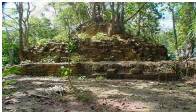
ภาพที่ 3.14 เจดีย์ประธานมีการใช้วัสดุก้อนอิฐขนาดใหญ่ มีลักษณะเป็นสี่เหลี่ยมถูกทิ้งร้างไว้ ก่อนได้รับการบูรณะจากกรมศิลปากร
