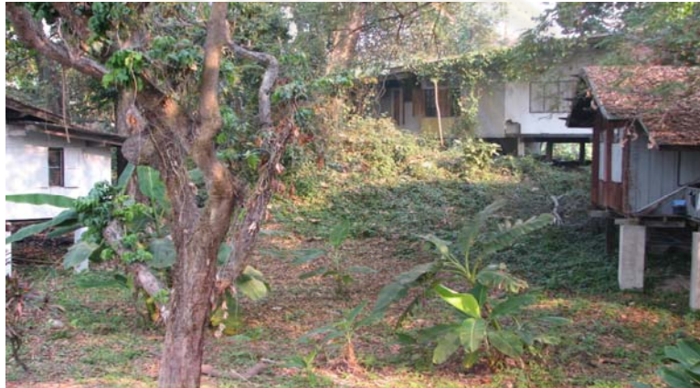
ภาพที่ 5.12 ชุมชนมีการบุกรุกแนวคันดินเพื่อใช้พื้นที่เป็นที่อยู่อาศัยหากปล่อยให้แบบนี้แนวคันดินอาจหายและพังทลายไปในที่สุด
